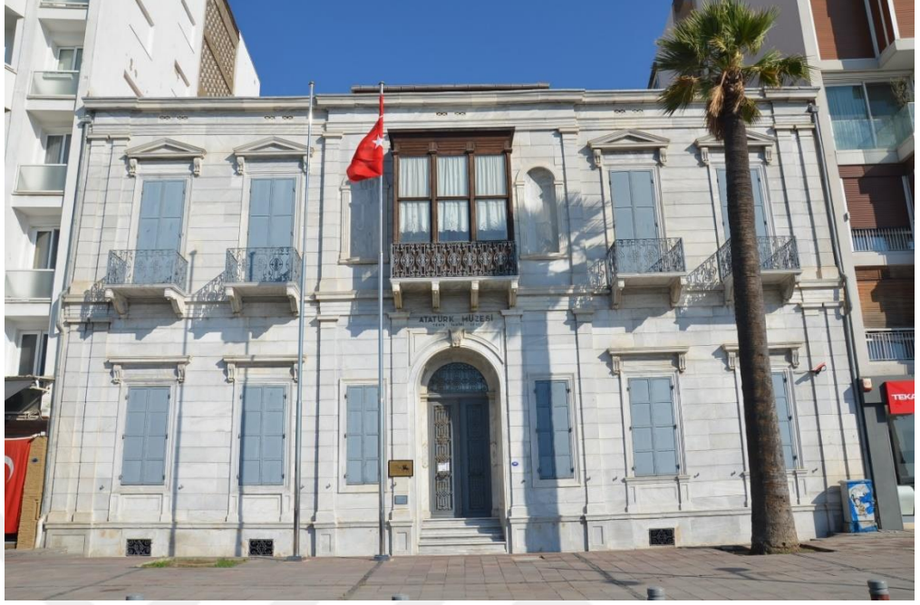
Fotoğraf 3: İzmir Atatürk Müzesi Binası Ön Cephesi
