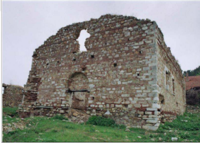
Şekil 4.7. Aya Yani Kilisesi Güneybatı'dan Genel Görünümü
