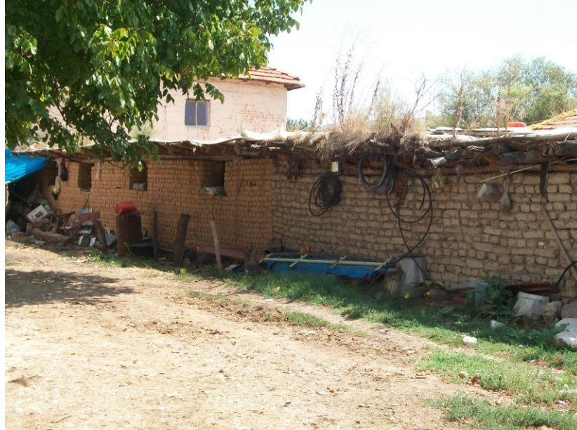
Cumhuriyet Köyü'nde Taş Duvarlı, Çatısı Saz Ve Kamıştan Yapılmış Düz Toprak Damlı Ahır.
