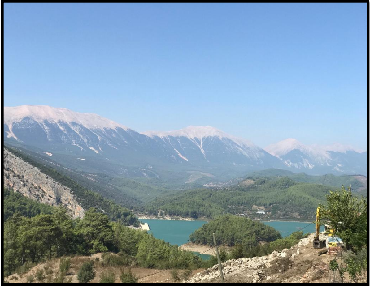
Fotoğraf 1.1 Sahanın Kuzeydoğusunda Bulunan Beydağları'ndaki Kaynak Sularının Oluşturduğu Alakır Barajı Sulama ve Taşkın Kontrolü Amacıyla Yapılmıştır.
