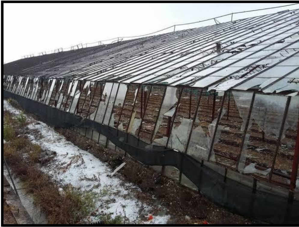
Fotoğraf 3.10 16.06.2018 Tarihli Dolu Afetinden Sonra Kasapçayırı Mahallesinde Hasar Gören Cam Sera
