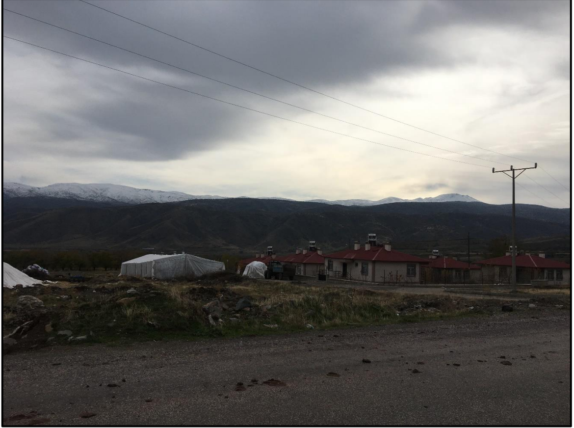
Fotoğraf 16. Kumyazı Köyünde Deprem Sonrası Yapılan Betonarme Konutlar
