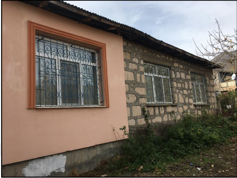
Fotoğraf 18. Kumyazı Köyünde Taş Konuta Betonarme Eklenti Örneği
