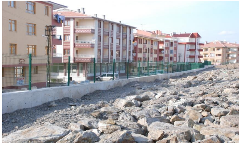
Şekil 3.7 Yıldırım Beyazıt Parkı İstinat Duvarının Dolgu Malzemesi ile Desteklenmesi
