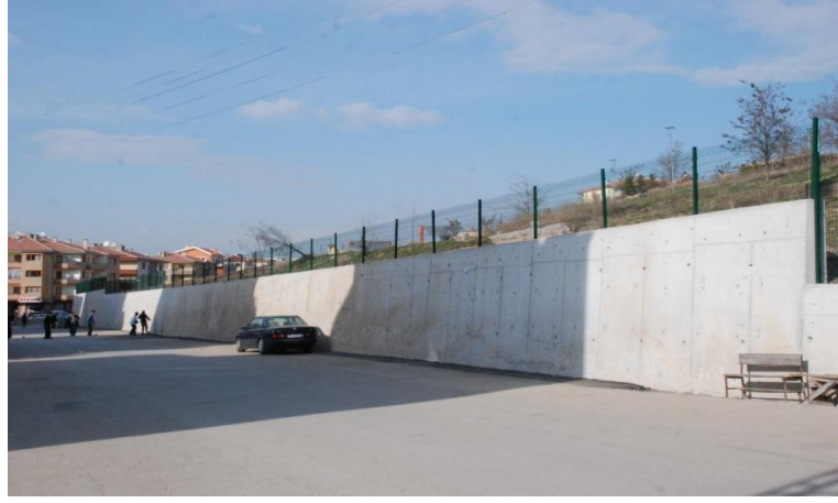
Şekil 3.5 Çevre İstinat Duvarından Bir Görünüm
