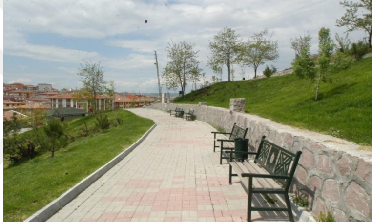
Şekil 3.6 Taş Duvar Uygulamasından Bir Görünüm
