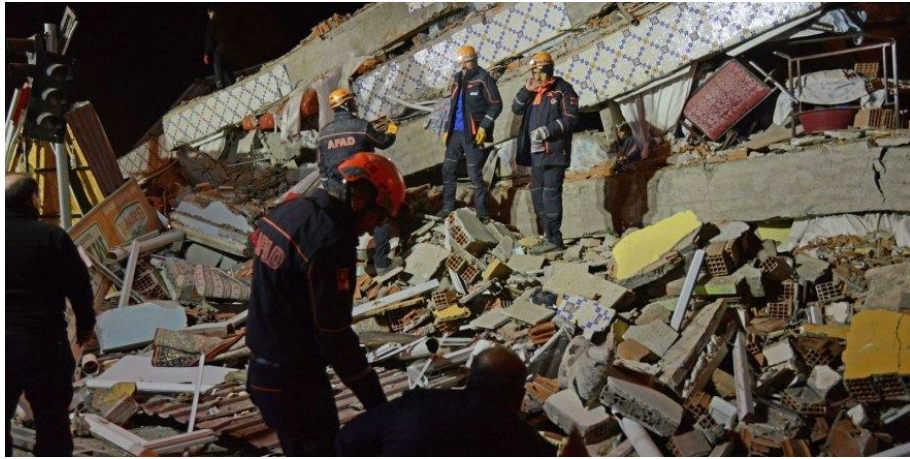
Şekil 3.14. Elazığ depreminde yıkılan evler (URL-1).
