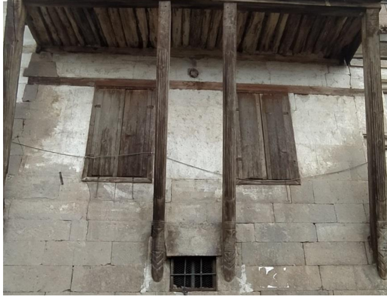
Şekil 4.21. Pencereilerin dış etkilere karşı korunması için alınan önlemler.
