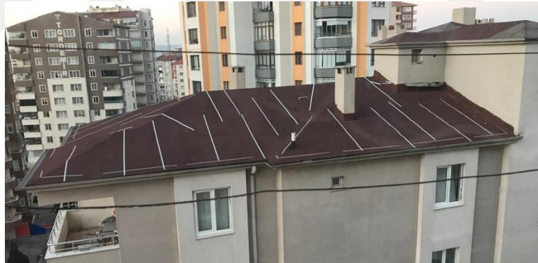
Şekil 4.26. Günümüz Talas konutlarında kırma çatı uygulaması.
