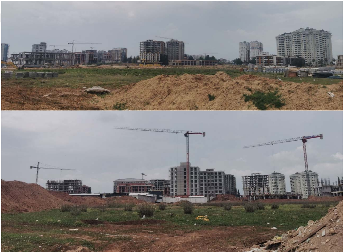
Şekil 3.90. Sahada yürütülen inşaat faaliyetleri (yazar tarafından 2023 mayıs ayında çekilmiş görüntülerdir.)
