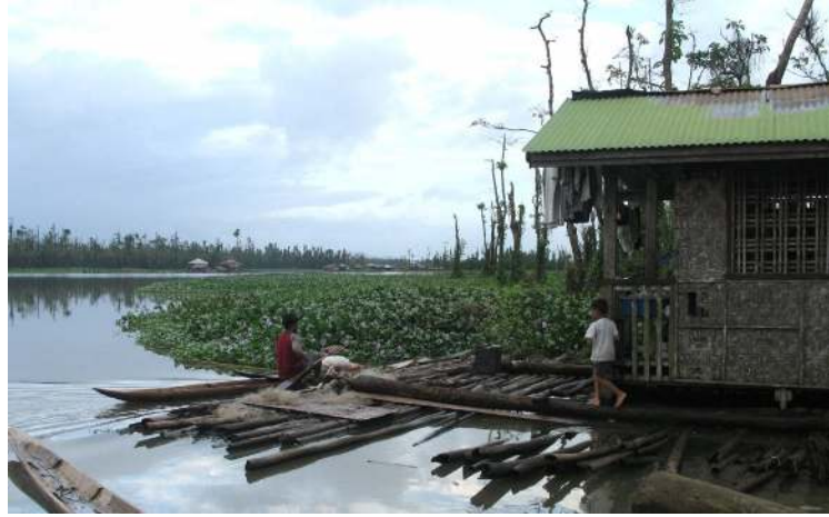
Şekil 3.11 Filipinler’de bambular üzerinde yüzen ev (Ties Rijcken)
