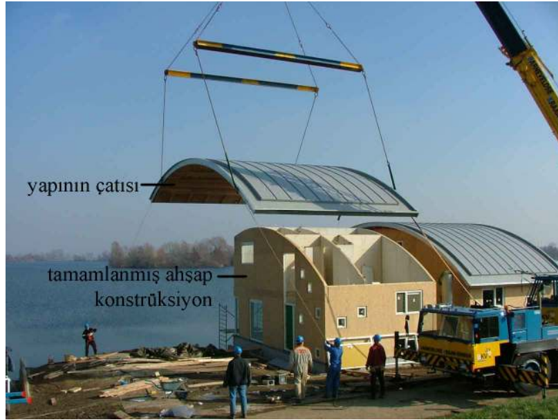
Şekil 4.8 Tamamlanmış yapının üzerine çatısının yerleştirilmesi (Karel Joosten)
