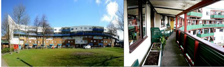
Şekil 3.8 : Byker Wall Yerleşkesi, Ralph Erskine, İngiltere, 1969-1982. (Url-24)
