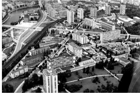
Şekil 2.21 : Hansa Viertel Mahallesi, Almanya, 1953. (Url-14)
