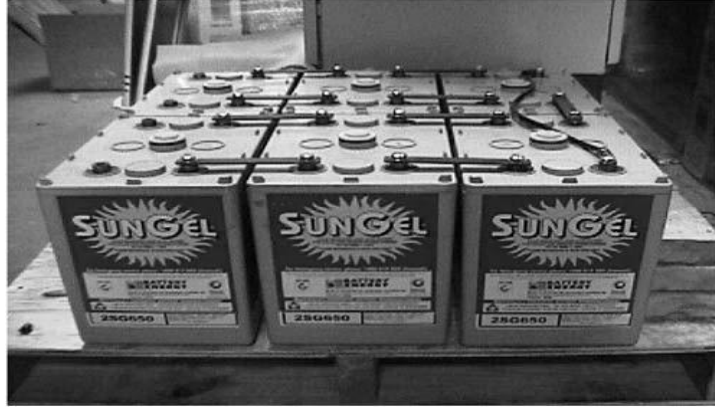
Şekil 1.20. Peru'nun Padre Cocha şehrinde kurulu bulunan bir uzak alan enerji sağlama sisteminde bulunan a) dizel motoru, b) Güneş panelleri ve c) VRLA akü sistemi
