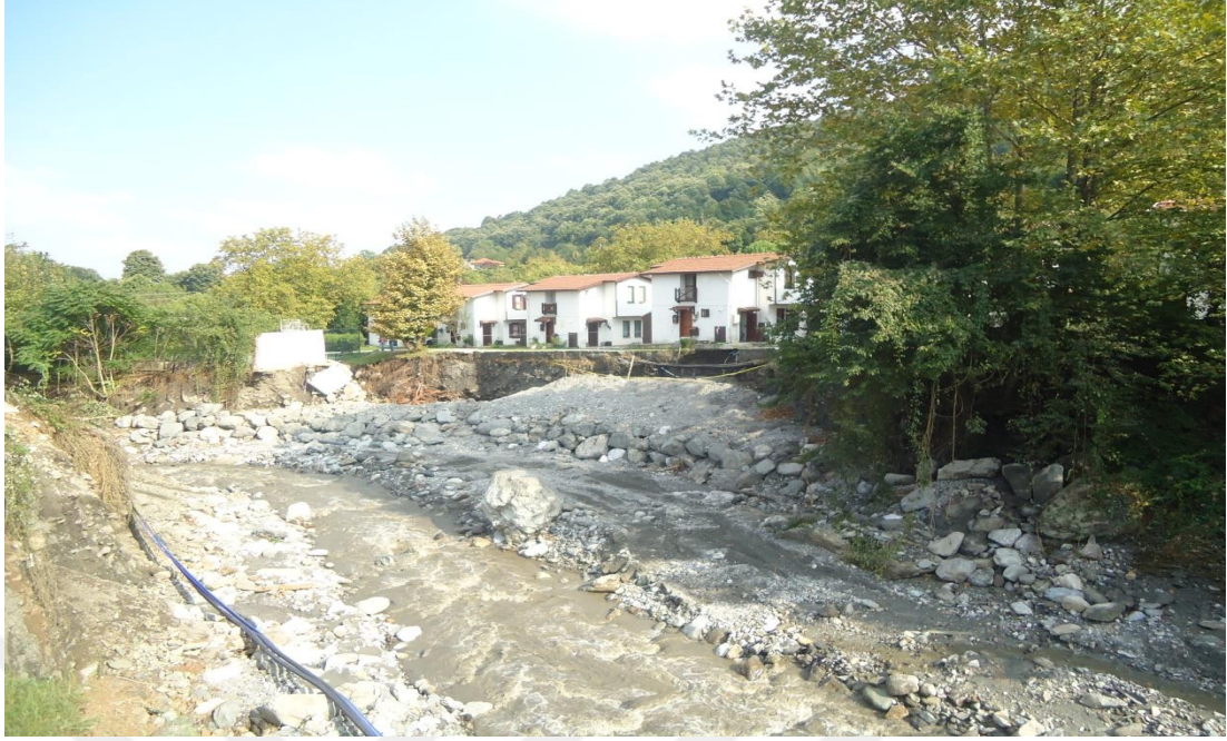
Şekil 5.20. Taşkın sonrası Kurtköy Deresinde meydana gelen kıyı erozyonu
