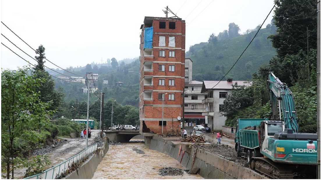
Şekil 2.5. Plansız yapılaşma örneği (URL 1).
