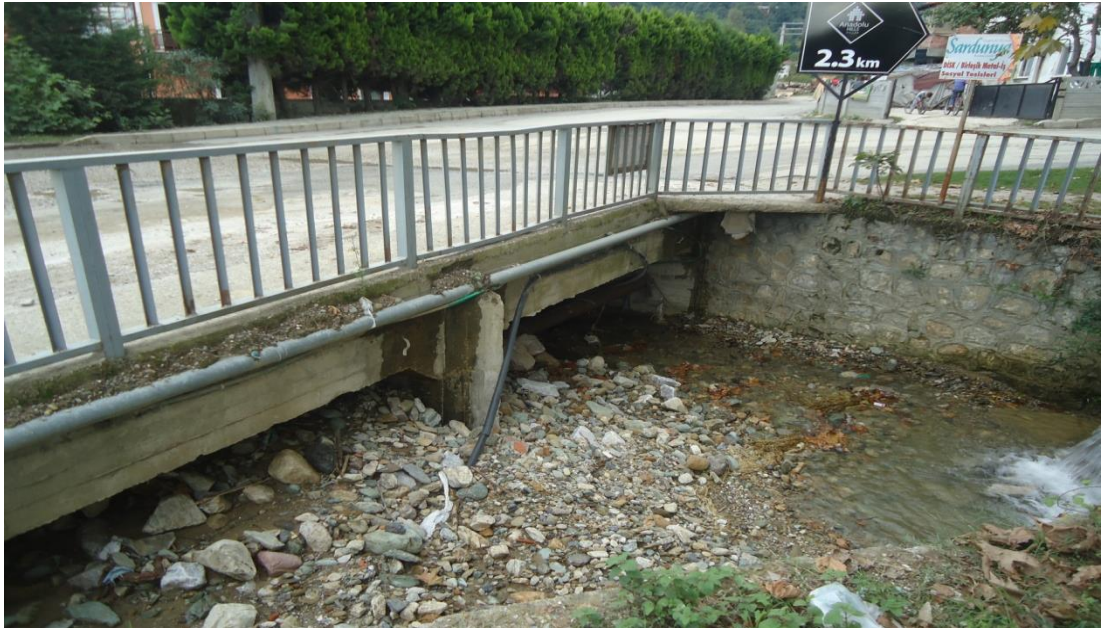
Şekil 5.21. Kurtköy Deresinde üst havzadan gelen sedimentin ulaşım yapılarına etkisi
