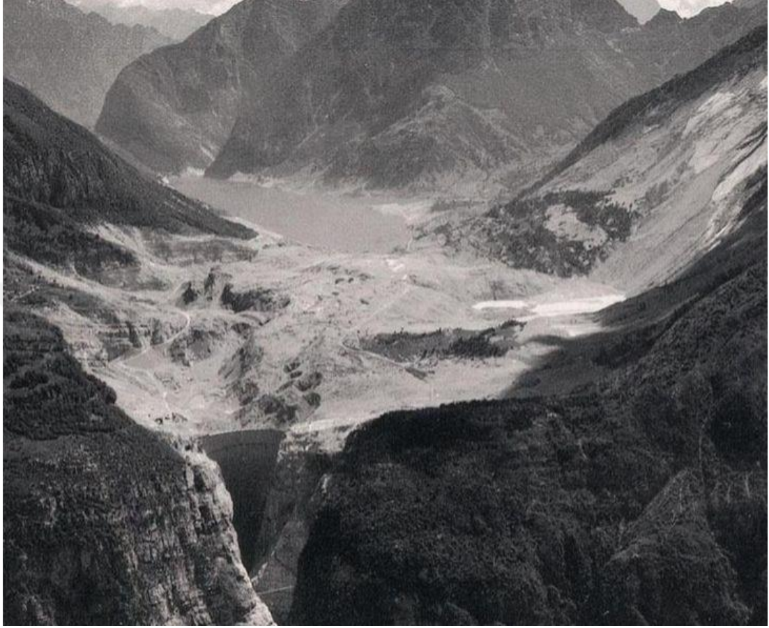
Şekil 2.7. Vaiont barajının yıkılması (URL 2).
