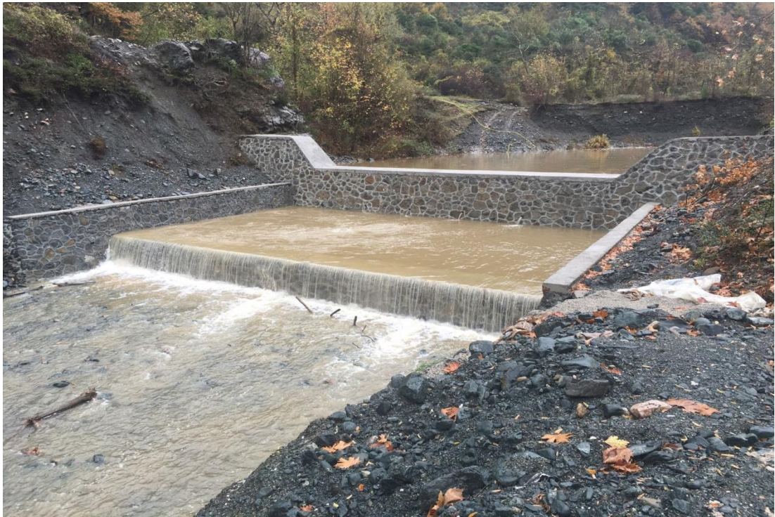
Şekil 2.14. Sakarya Doğançay Deresinde inşa edilen harçlı kargir bendi
