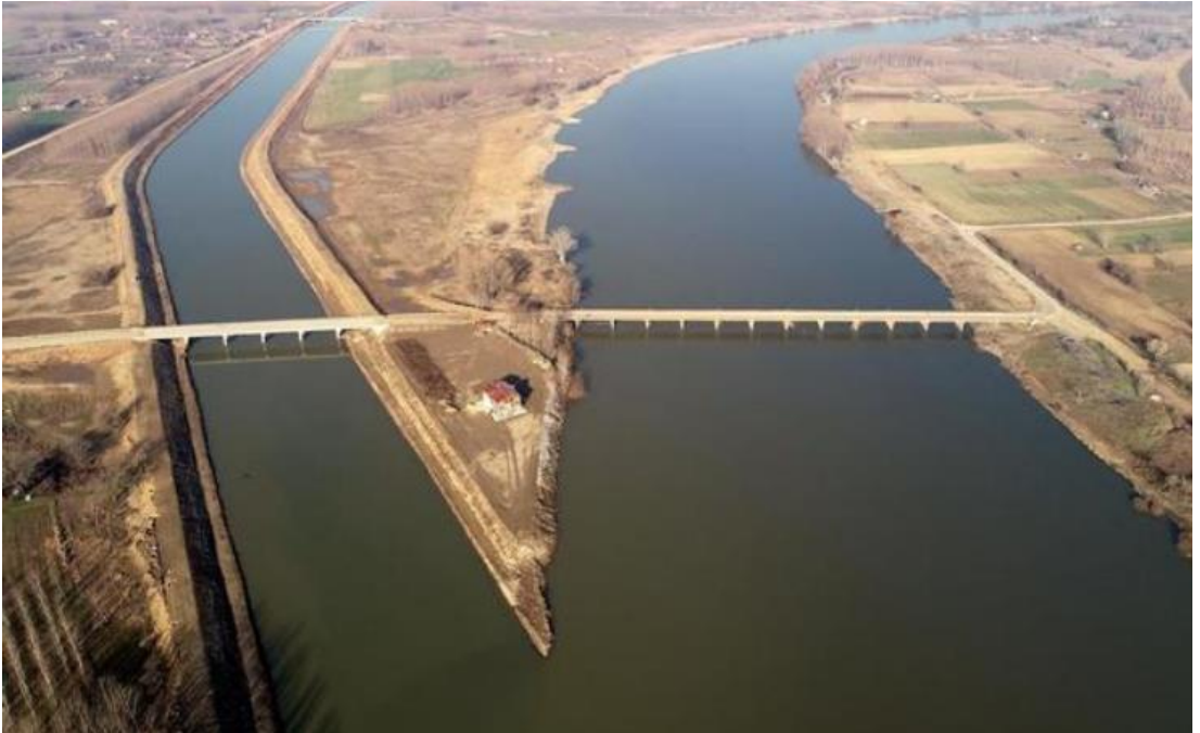
Şekil 2.9. Meriç Nehrinde uygulanan taşkın kanalı (URL 3).
