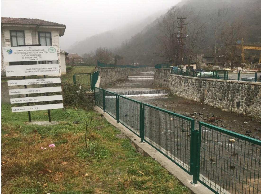
Şekil 2.13. Sakarya Doğançay Deresinde inşa edilen taşkın duvarları
