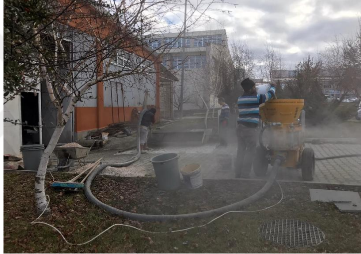
Şekil 3.6. Püskürtme beton makinesine karışımın ilave edilmesi
