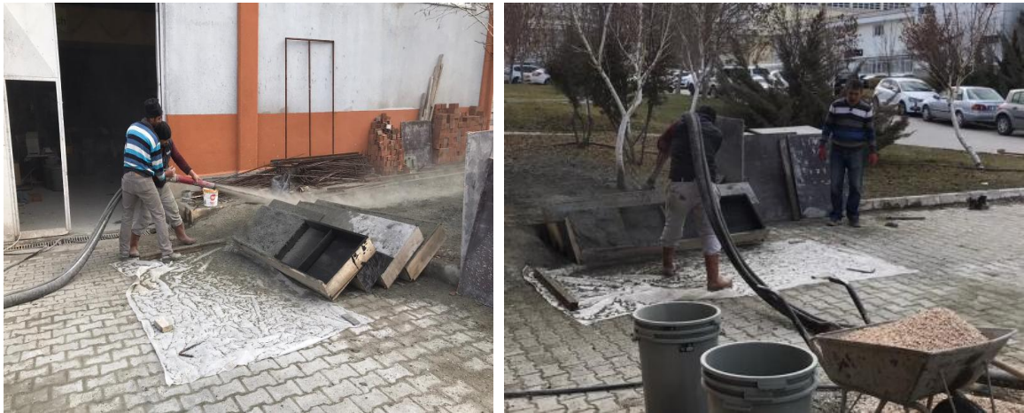
Şekil 3.7. Püskürtme beton uygulaması
