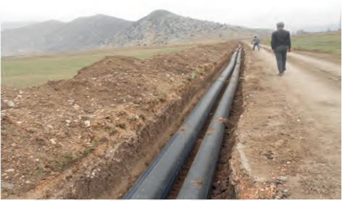
Şekil 6. Sulama amaçlı boruların döşenmesi
