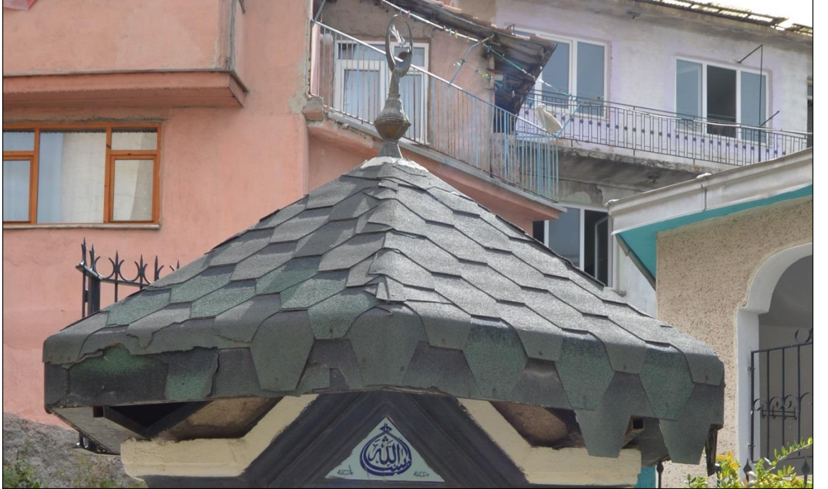
Fotoğraf 70: Çeşmenin Günümüz Malzemesi Olan Çatı Kaplaması (shingle)
