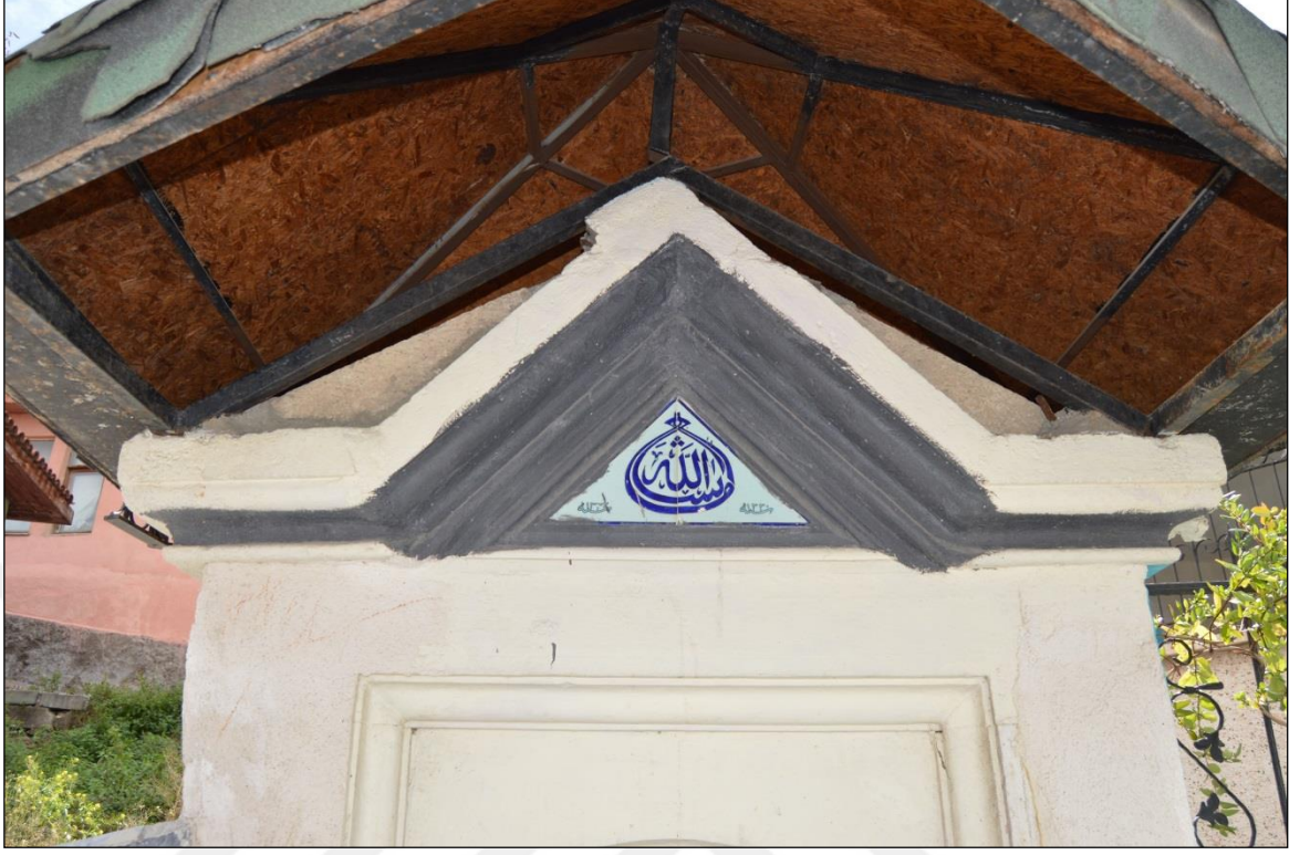
Fotoğraf 70: Çeşmenin Günümüz Malzemesi Olan Çatı Kaplaması (shingle)
