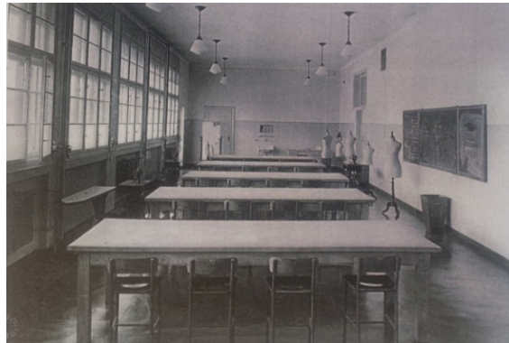
Şekil 5.63 : İsmet Paşa Kız Enstitüsü, Giyim Atölyesi (Alpagut, 2012, s. 186).
