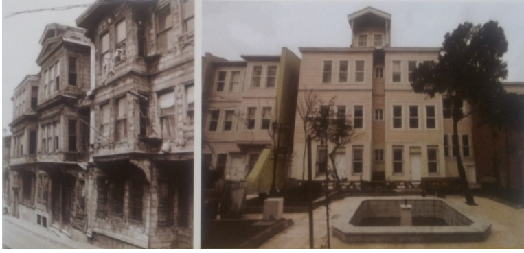
Şekil 4.2 : Süleymaniye’de bulunan Kayserili Ahmet Paşa Konağı (Eski ve restorasyondan sonraki halleri) (Erdem ve Yiğit, 2010, s. 99).
