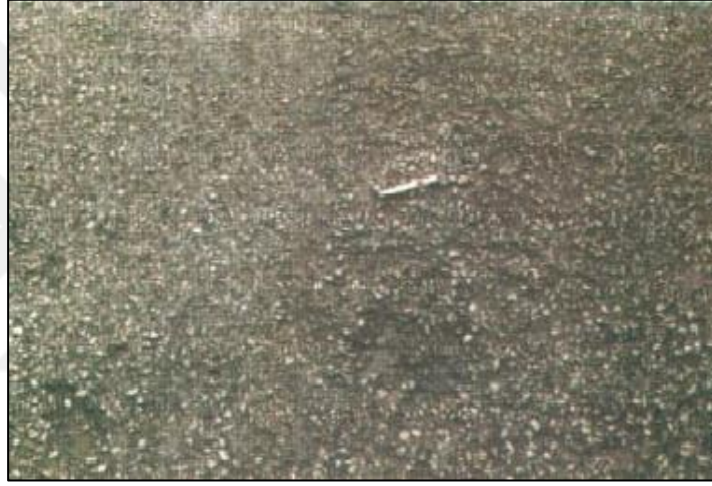
Şekil 2.8. Orta şiddette soyulma/sökülme (KGM, 2008).
