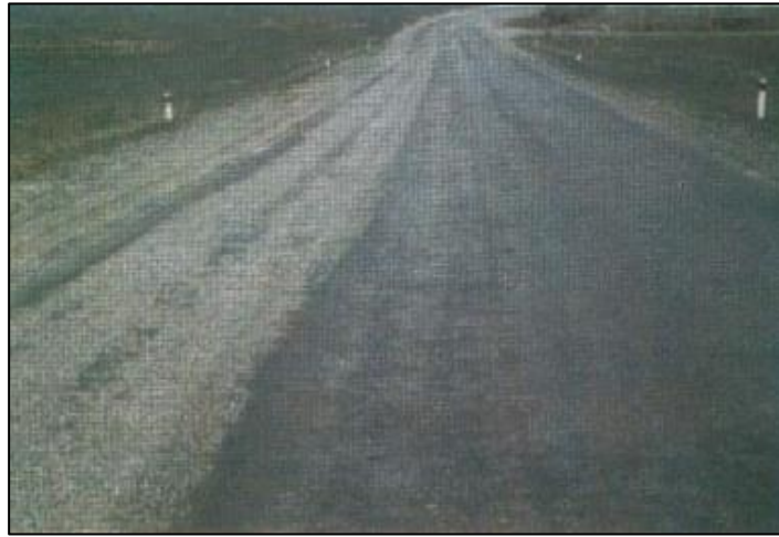
Şekil 2.9. Yüksek şiddette soyulma/sökülme (KGM, 2008).
