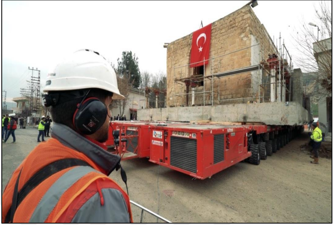
Şekil 3.16. Yapı + SPTM modül taşıyıcı.
