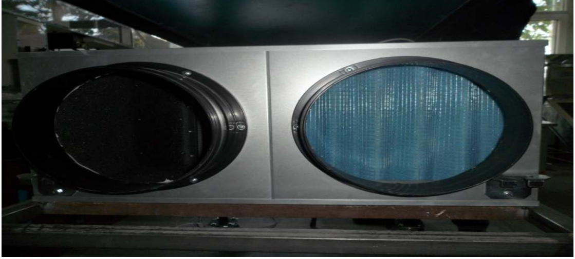
Resim 3.6. Isı geri kazanım cihazı ön görünüşü
