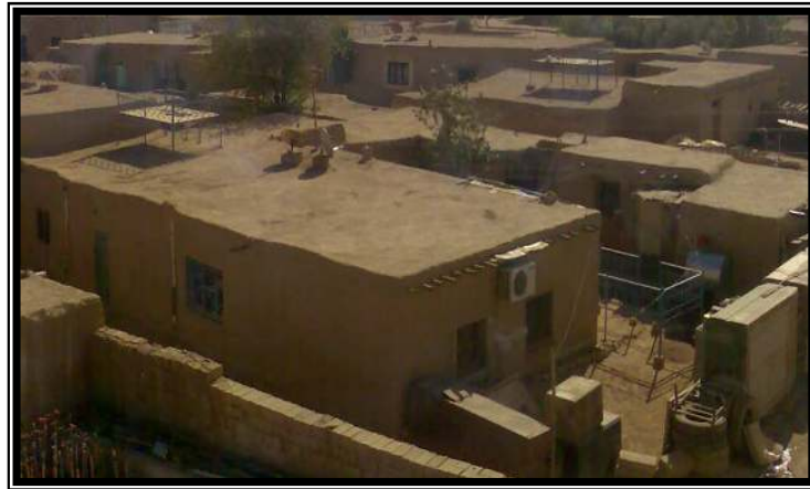
Foto 9: Büyükboğaziye Köyü'nde Düz, Toprak Çatı Mesken Tiplerinden Bir Görünüm. Araştırma alnımızda kırsal alanda yerleşmelerin önemli bir kısmında toprak yapı malzemesinin yanında çatı tipleri de topraktan olup düz şeklindedir
