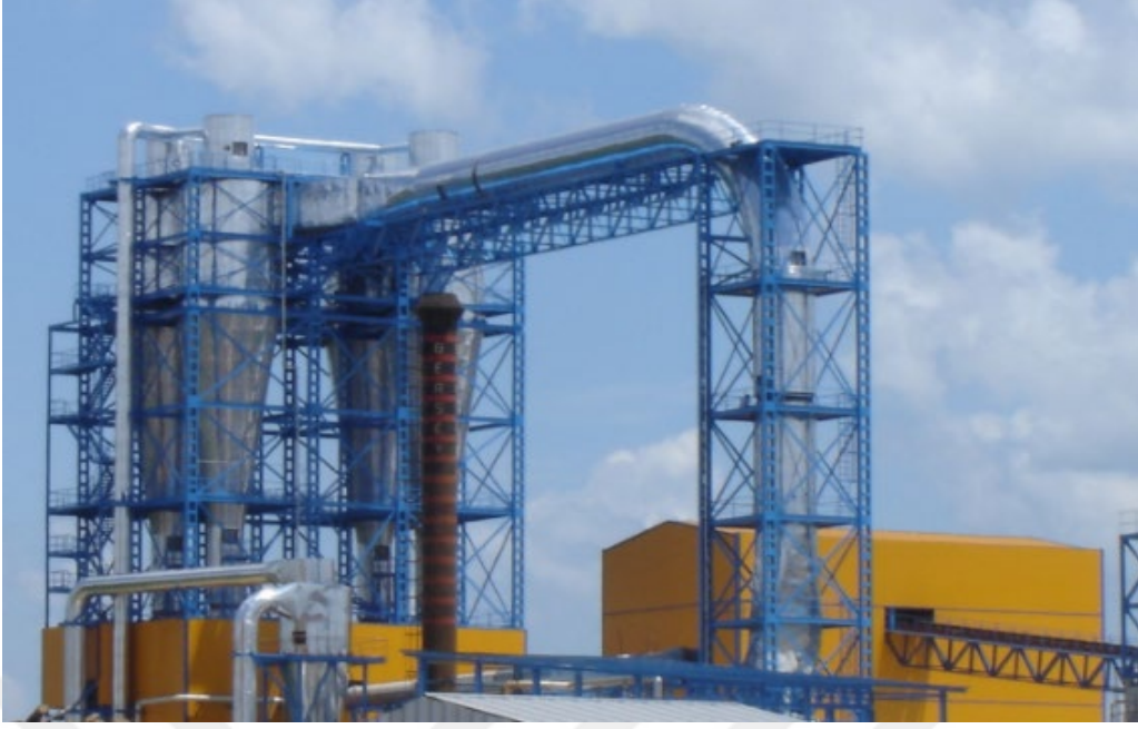
Şekil 1.55: 4 Siklonlu Lif Kurutma Sistemi (URL-34, 2017)
