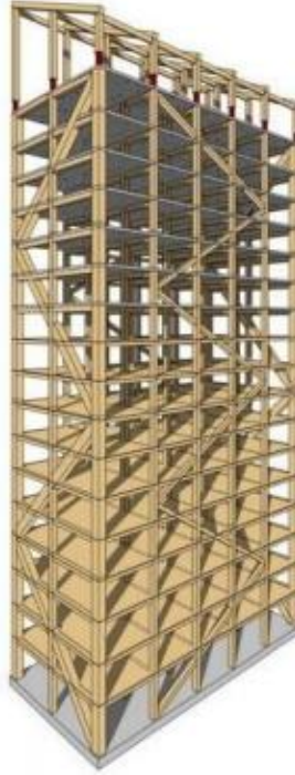
Şekil 2.8 Taşıyıcı iskelet sistemi lamine ahşap olan Mjos Tower, Norveç (Çağlayan, 2020)
