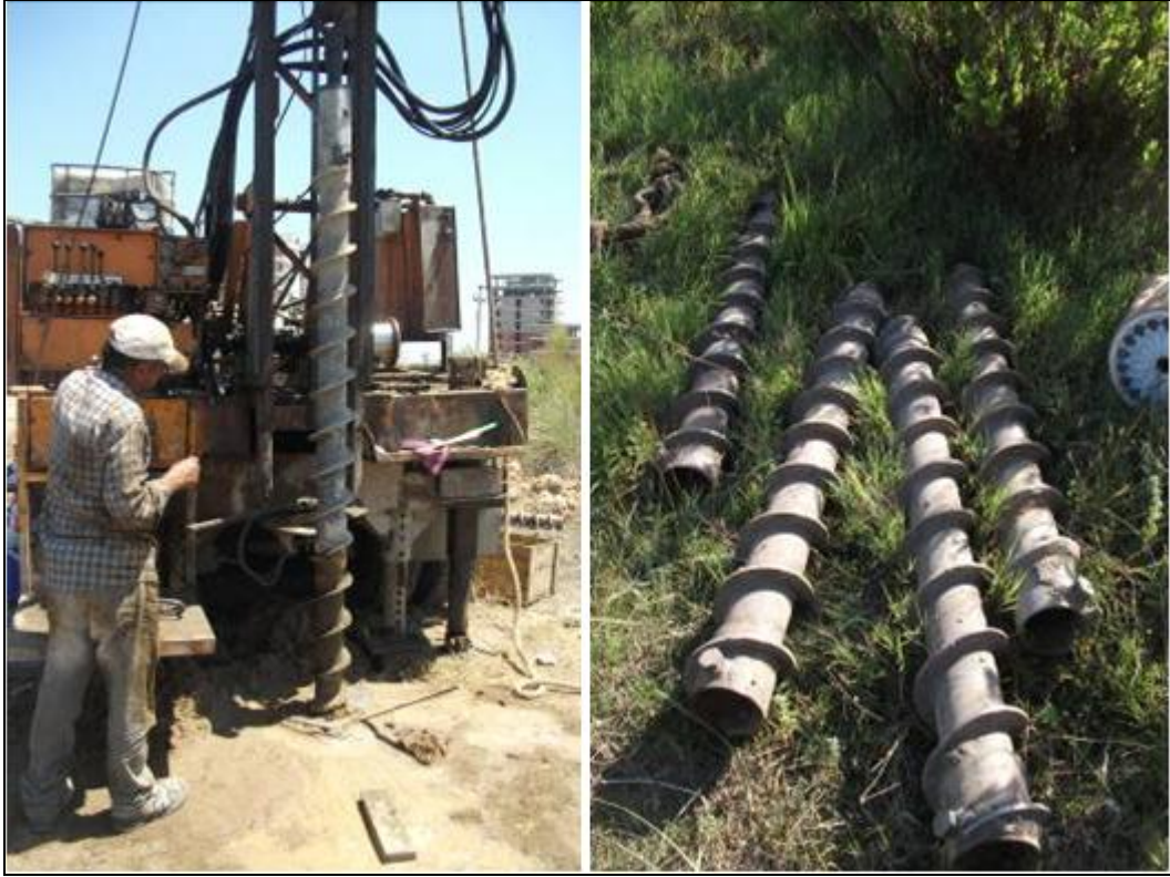
Şekil 3.1 Çalışma kapsamında kullanılan sondaj makinesi ve augerler
