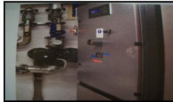
Resim 5.6. Kojenerasyon ünitesi [52]
