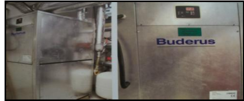
Resim 5.7. Toprak kaynaklı ısı pompaları [52]
