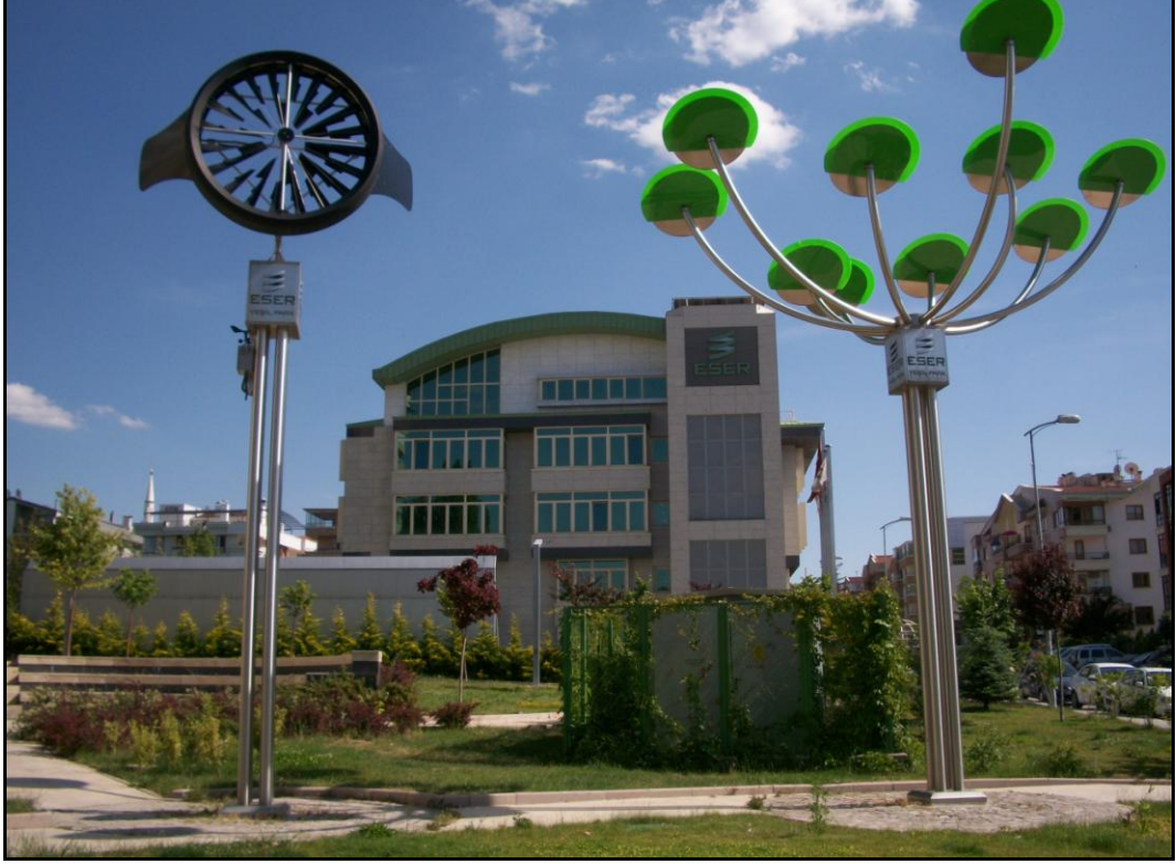
Bina kuzey (sol yan) cephe görünüşü [50]
