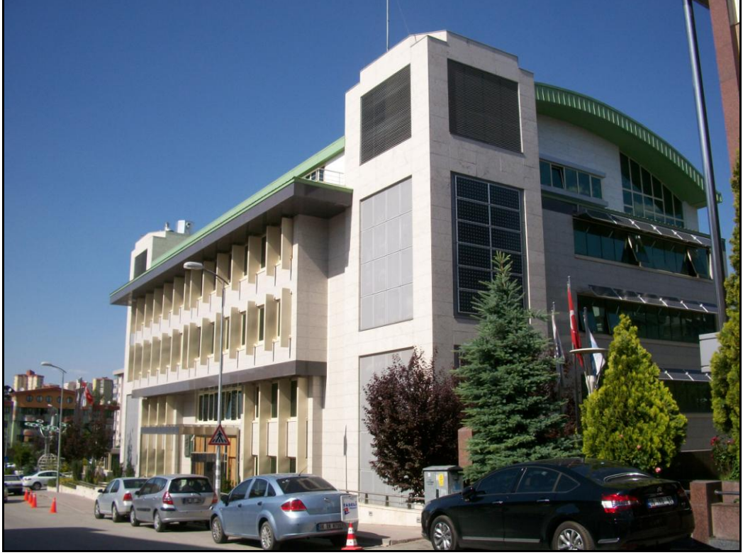
Bina sağ yan cephe görünüşü [50]
