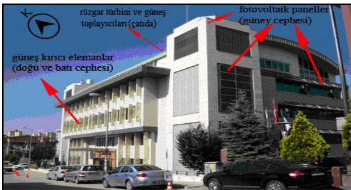
Resim 5.3. Binada uygulanan yenilenebilir enerji sistemleri [50]
