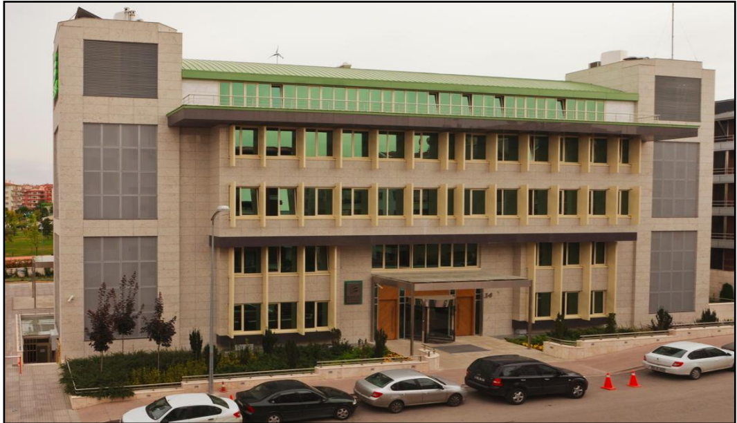
Bina batı (ön) cephe görünüşü [36]
