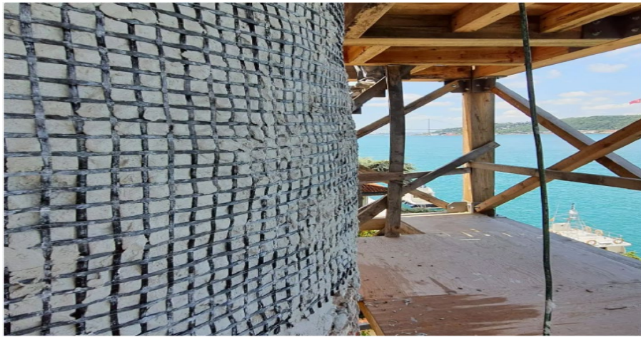
Şekil 2. 3. Bazalt lif ağı ve çimento bazlı sıva harcının uygulaması
