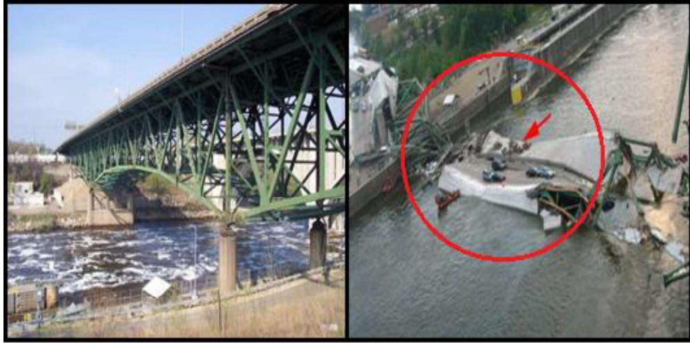
Şekil 1.5 Minneapolis şehrinde I-35W köprüsünün yorulma kaynaklı göçmesi (Roberts, b.t)
