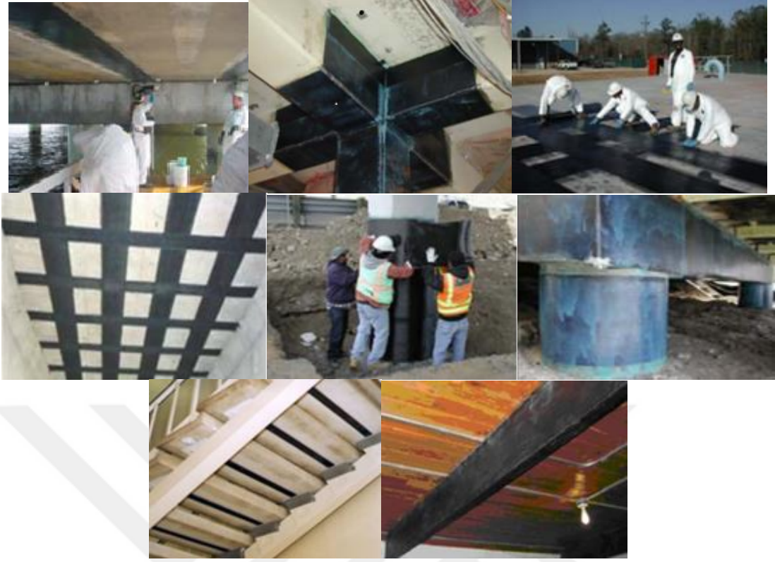
Şekil 3.8. Yapı elemanlarında karbon elyaf ile güçlendirme örnekleri (Anonim)
