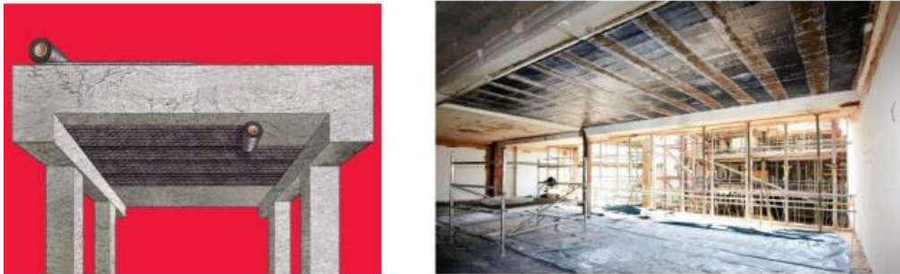
Şekil 3.12. Döşemelerde lifli polimerle güçlendirme uygulaması (Anonim)
