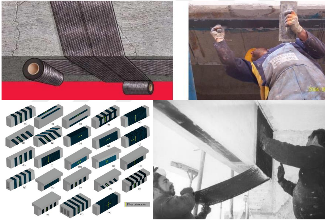
Şekil 3.10. Kirişlerin güçlendirilme şekilleri (Alabdulhady ve Sneed, 2019- Anonim)
