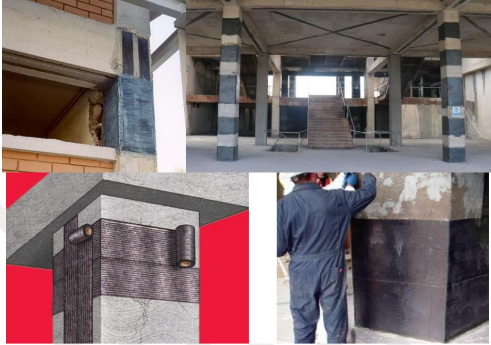
Şekil 3.11. Kolonlarda ve perdelerde Lifli polimerle güçlendirme uygulaması (Anonim)
