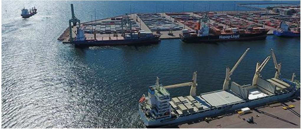
Şekil 11. Hamina Kotka Limanı
