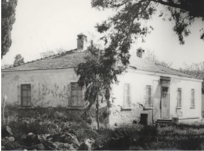
Şekil 10: Tarihi Urla Tahaffuzhanesi Hastane Binası
