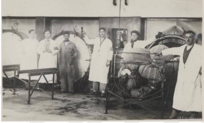
Şekil 11: Urla Tahaffuzhanesi'nde Etüv Makinesiyle Dezenfekte İşlemi
