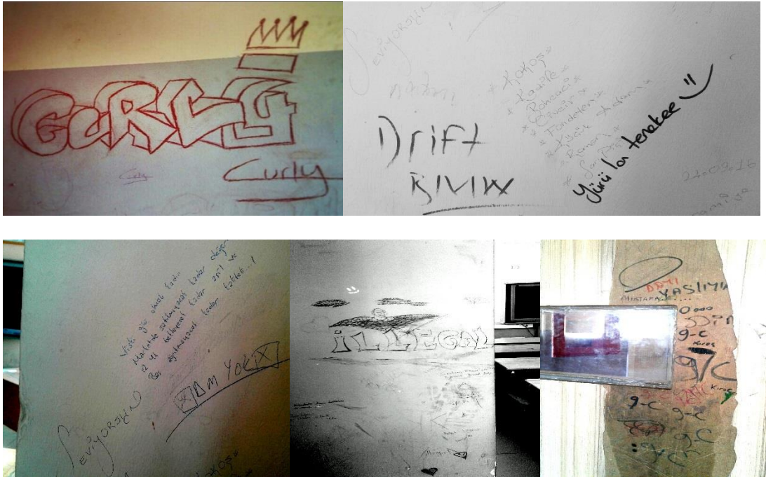
Şekil 23: Ahi Evran Mesleki Ve Teknik Anadolu Lisesi Sınıf Duvarları Ve Kapıları
