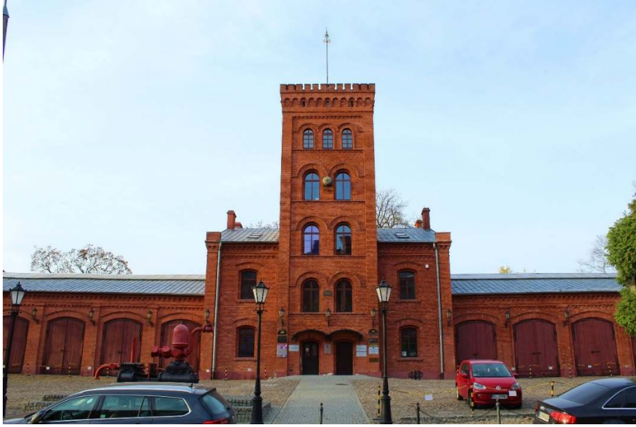
Şekil 8.35. Yenilenen itfaiye binası
