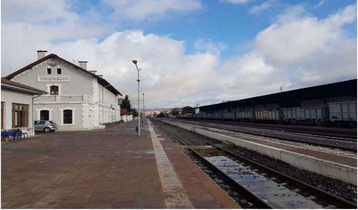
Şekil 2. 17. Uşak Yolcu İstasyonu ve Deposu
