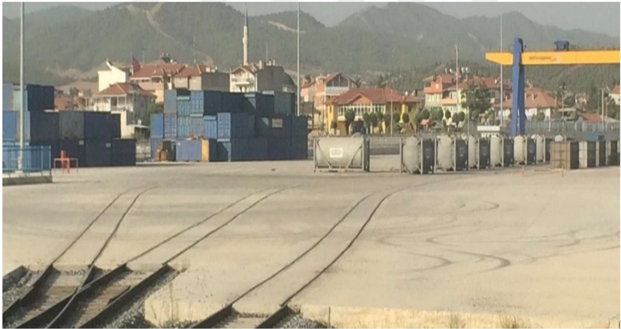
Şekil 2. 15. Denizli-Kaklık Lojistik Üssü İdari Binası ve Yükleme/Boşaltma Alanı
