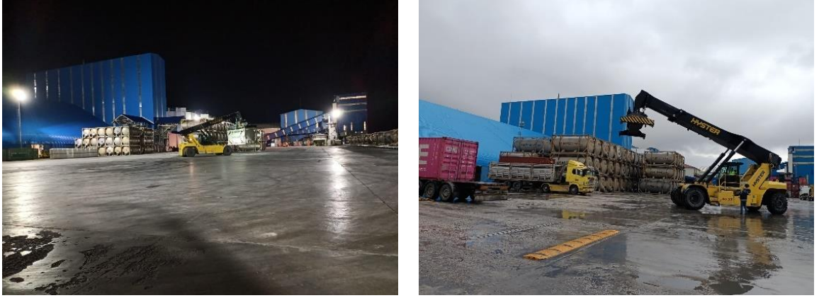
Görsel 4.1 Konteyner İstif Sahası ve Rampa Bölümü (Tarařımızca Çekilmiştir)
