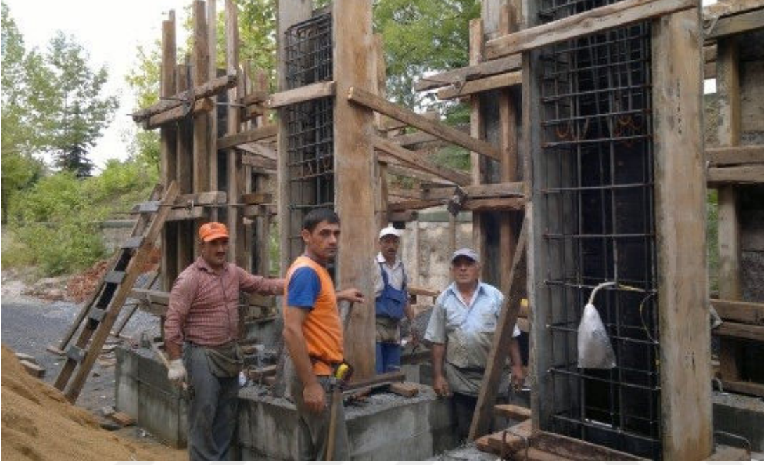
Şekil 2.12 : Kolon kalıplarının hazırlanması.
