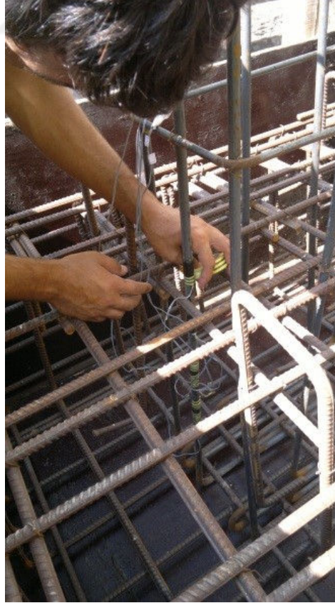
Şekil 2.5 : Şekil deęiřtirme ۆlerlere N-1 srlmesi ve VM bant yapıřtırılması.
