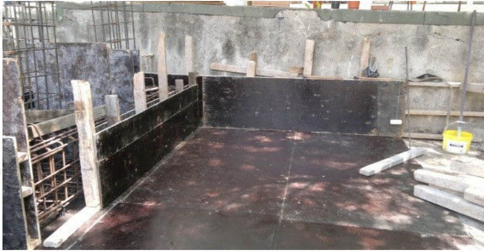
Şekil 2.6 : Temel kalıplarının çakılması ve donatı iskeletlerinin yerleştirilmesi.
