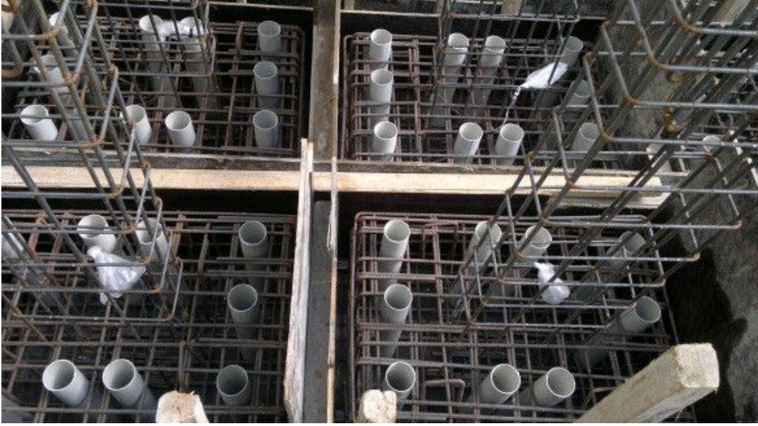
řekil 2.8 : PVC boruların temel ierisine yerleřtirilmesi.
