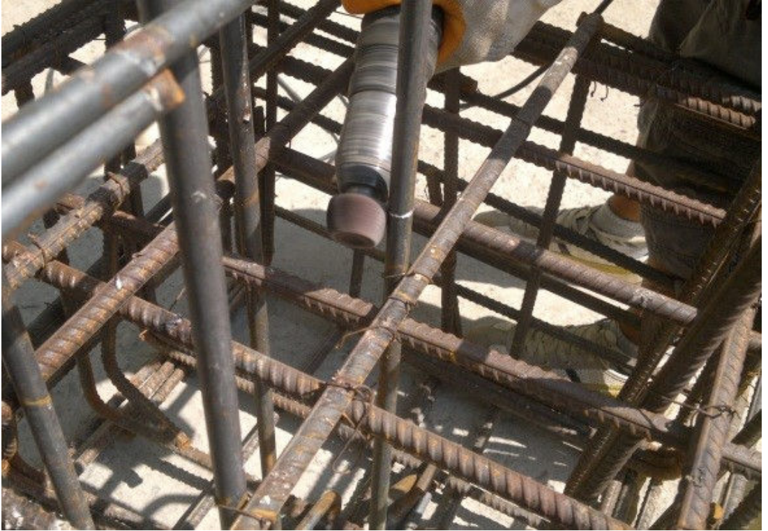
Şekil 2.3 : Donatıların üzerindeki pasın zımpara yardımı ile temizlenmesi.
