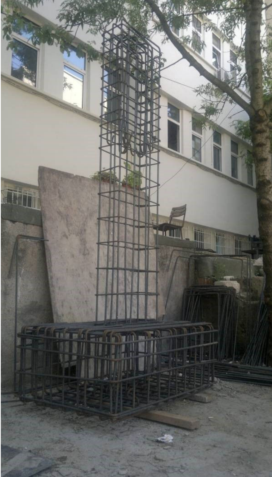
Şekil 2.2 : Donatı iskeleti.
