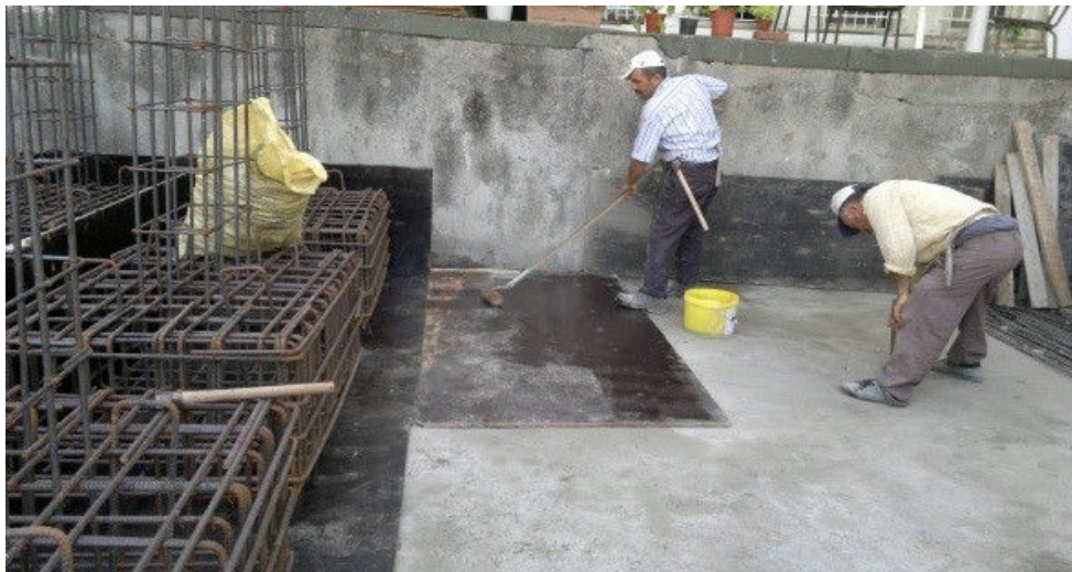
Şekil 2.7 : Temel kalıplarının çakılması ve donatı iskeletlerinin yerleştirilmesi.
