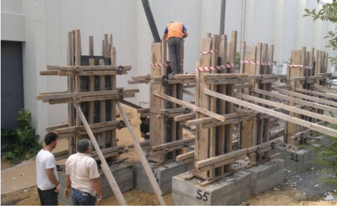
Şekil 2.13 : Kolon betonu dökümü.
