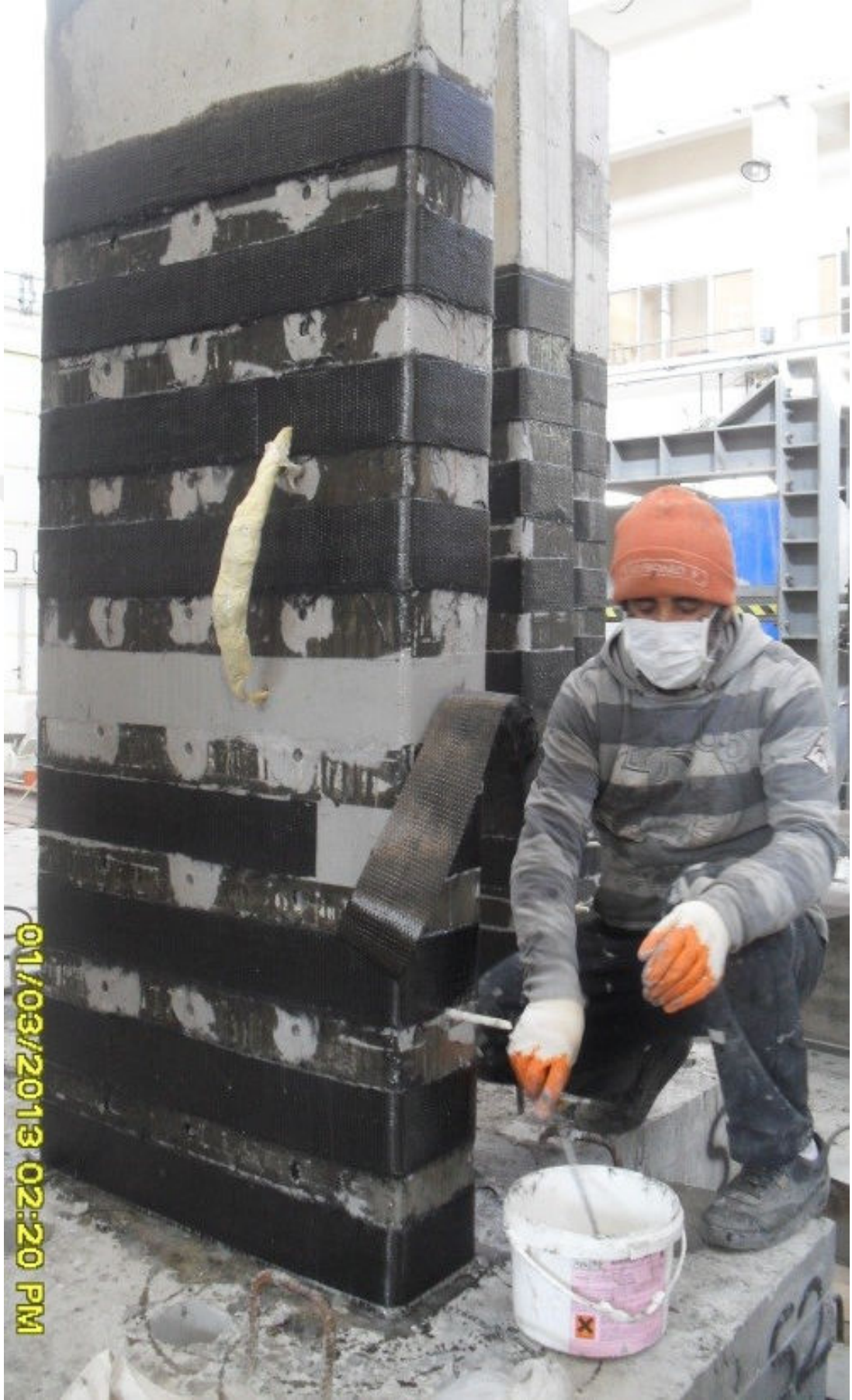
Şekil 2.18 : Karbon lifli polimer kompozit uygulaması.
