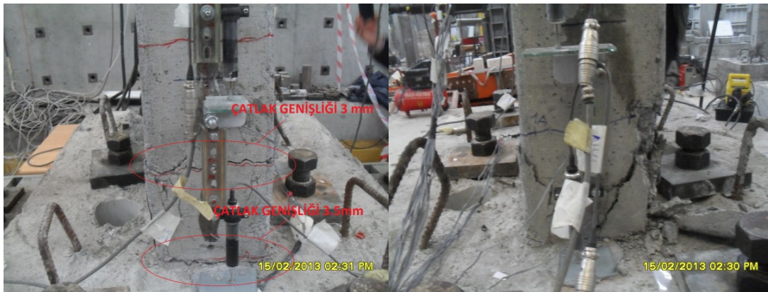
Şekil 4.7 : +0.02 görelî ötelemede çatlak genişlikleri ve hasar durumu.
