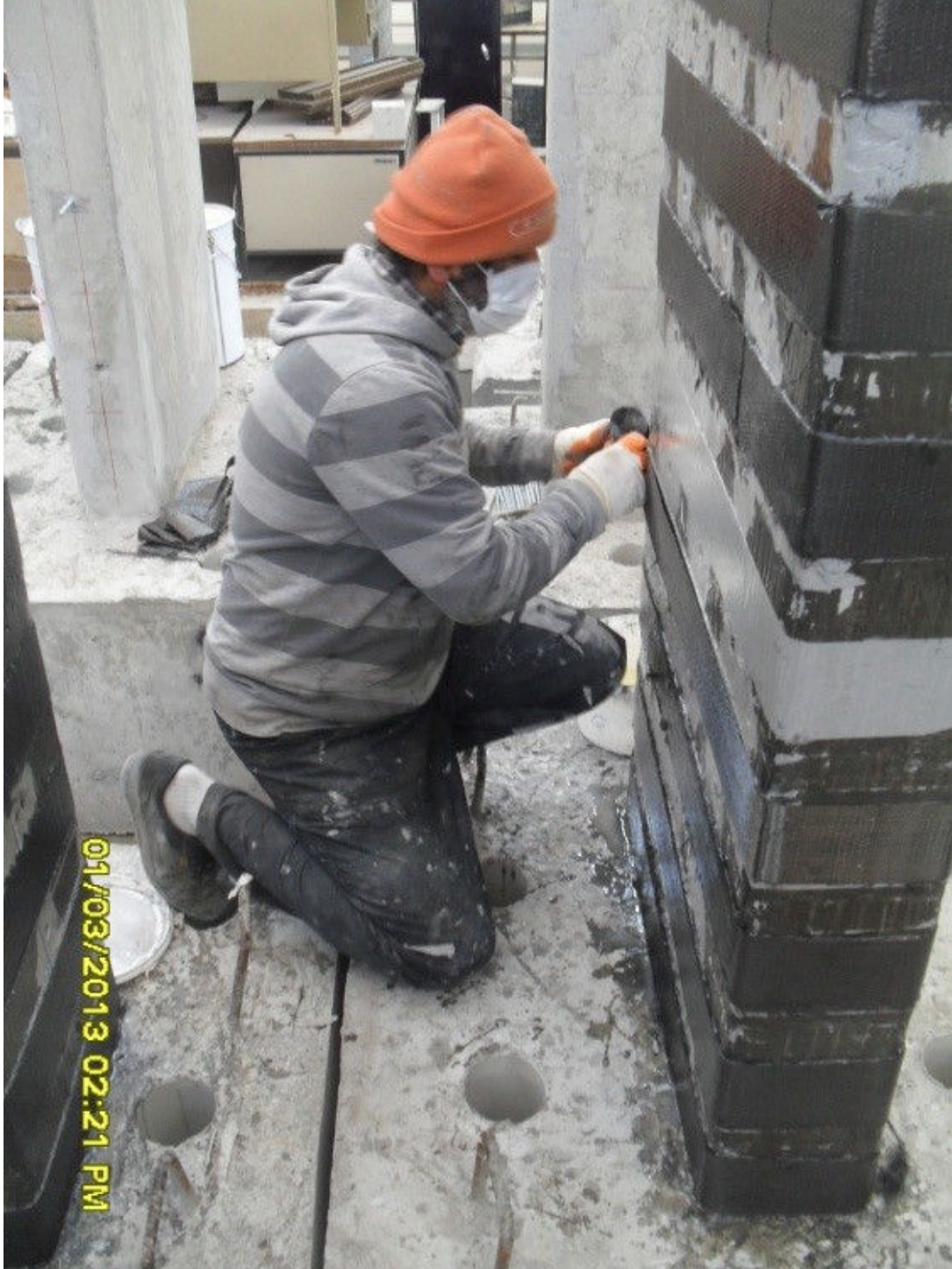
Şekil 2.19 : Karbon lifli polimer kompozit uygulaması.
