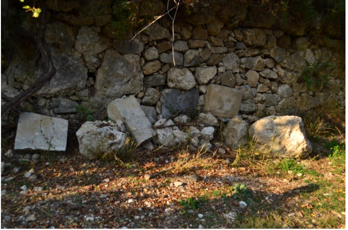
Resim: 5 Hippokome, Bahe Duvarlarında Blok Tařlar.
