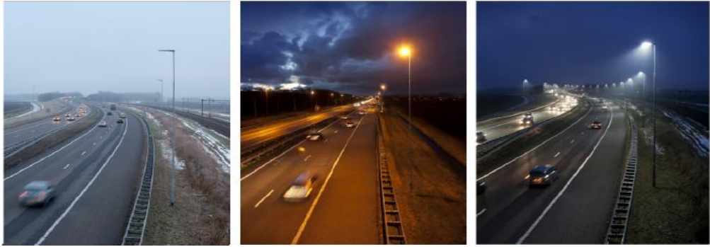
Şekil 2.4. Renk dönüşüm endeksi; doğal ışık altında yol görünümü (sol), YBSB (orta) ve LED (sağ) (DFI, 2014).
