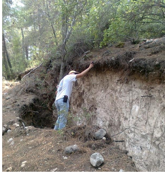
Şekil 2.10 Bir açık ocak şevinin arka kısmında oluşan gerilme çatlağı
