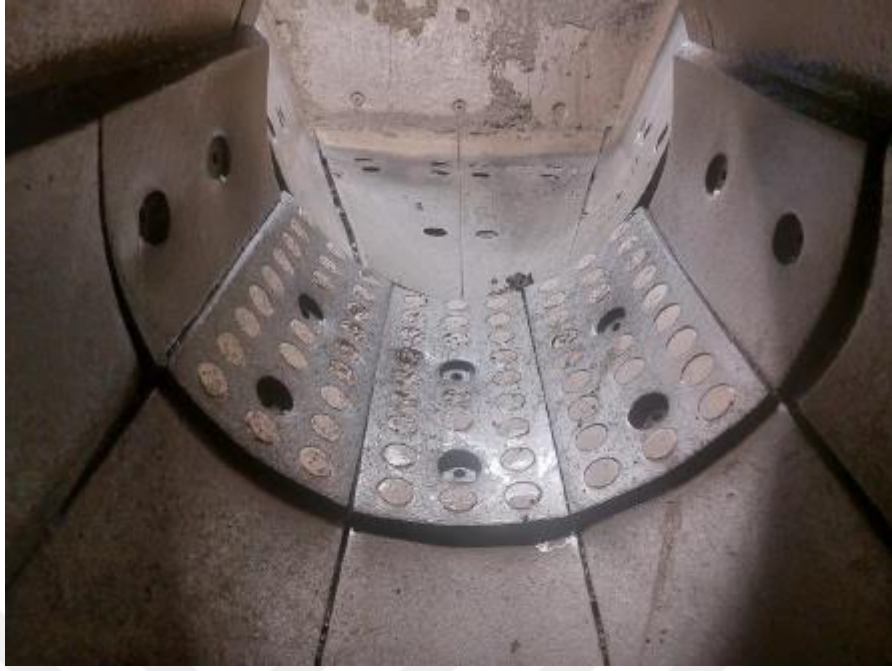
Şekil 36. Demir Export İspir işletmesinde SAG değirmen besleme şutuna montaj edilen Hardox 450 + alümina + neopren hibrit aşınma plakalarının 7. gün sonundaki durumu
