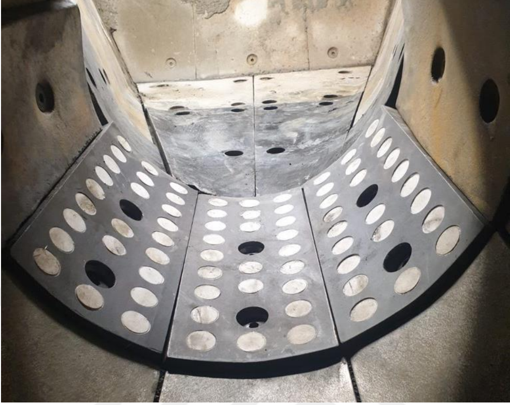
Şekil 24. Demir Export İspir işletmesinde bulunan SAG değirmen besleme şutuna Hardox 450 + alümina hibrit aşınma plakalarının montajı
