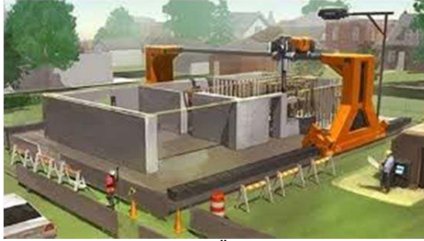
Şekil 5.2. 3D yazıcı ile ev yapma teknolojisi (Özdemir, 2019).
