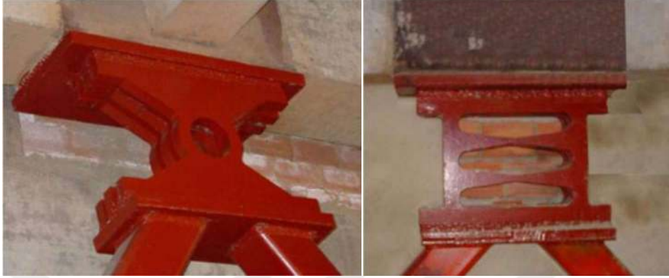
Şekil 1.5. Yuvarlak delikli ve X şekilli sönümleyici [10]
