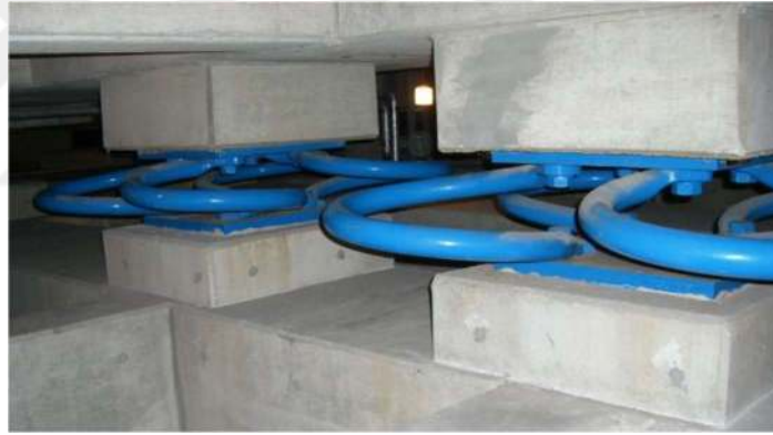
Şekil 1.11. Sarmal yay sistemli elastoplastik sönümleyici [10]
