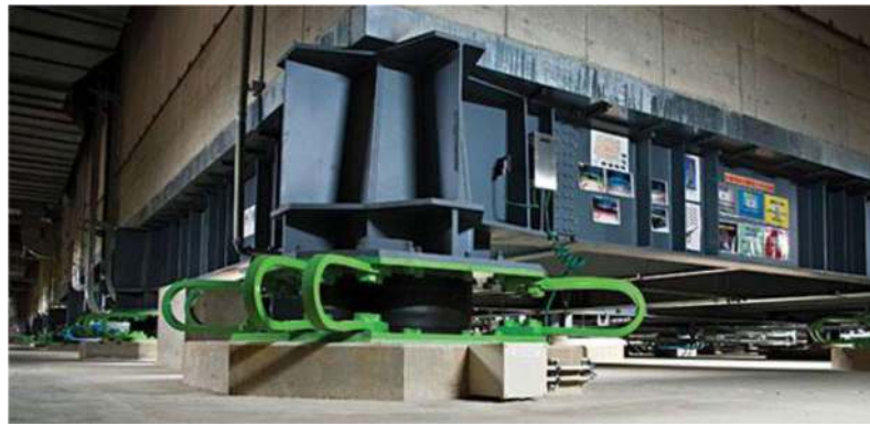
Şekil 1.12. U şekilli çelik sönümleyici [10]
