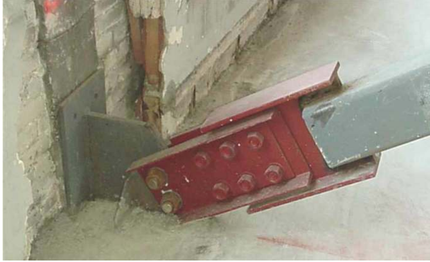
Şekil 1.14. Pall tipi sönümleyici tipik birleşim detayı [16]
