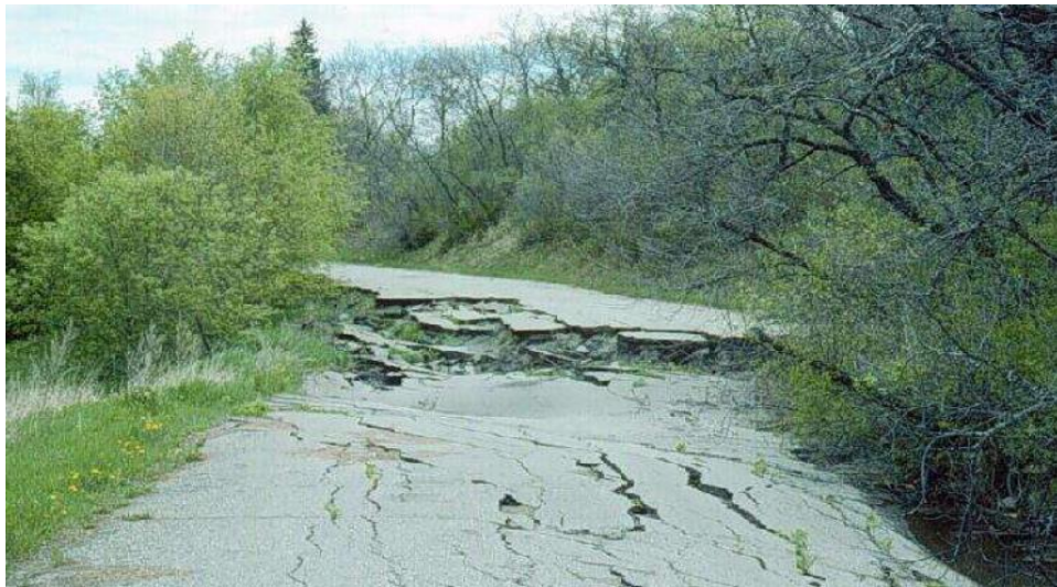
Şekil 6. Yanal yayılma heyelanı (Ersoy, 2020)
