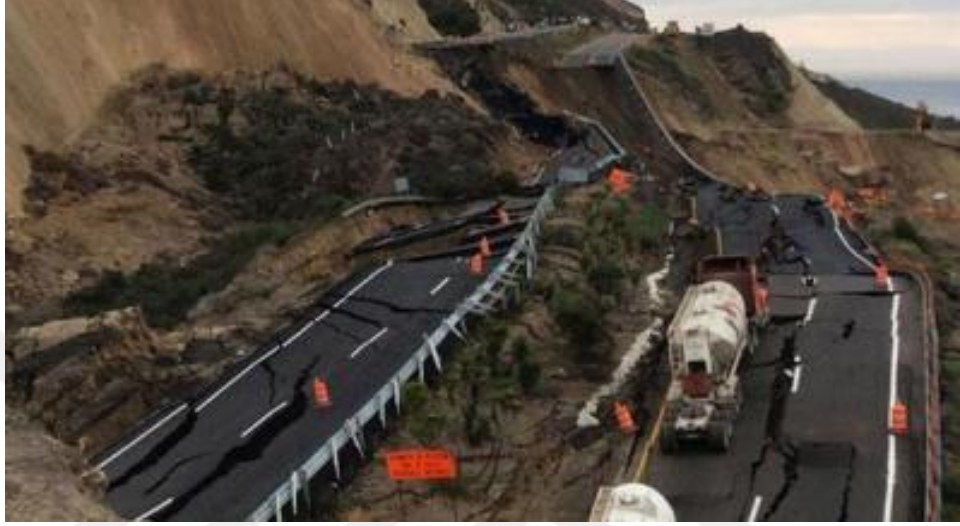
Şekil 5. Meksika’da meydana gelen çoklu dairesele kayma heyelanı (KGM, 2015)
