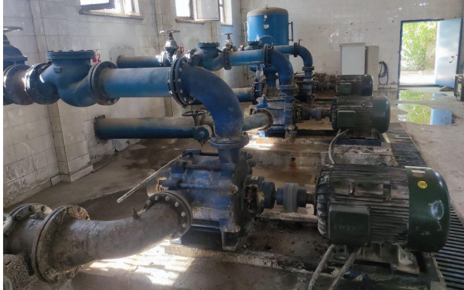
Şekil 1.5. Yatay milli santrifüj pompa (Bismil Terfi Merkezi, B 3’lü grup)
