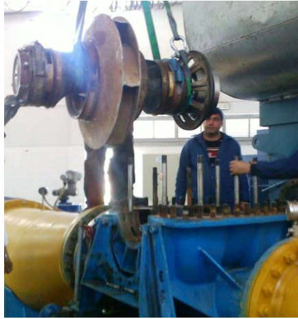
Şekil 1.8. Tek kademeli yatay milli santrifüj pompa montajı (Dicle Pompa İstasyonu, 4.000 kW)
