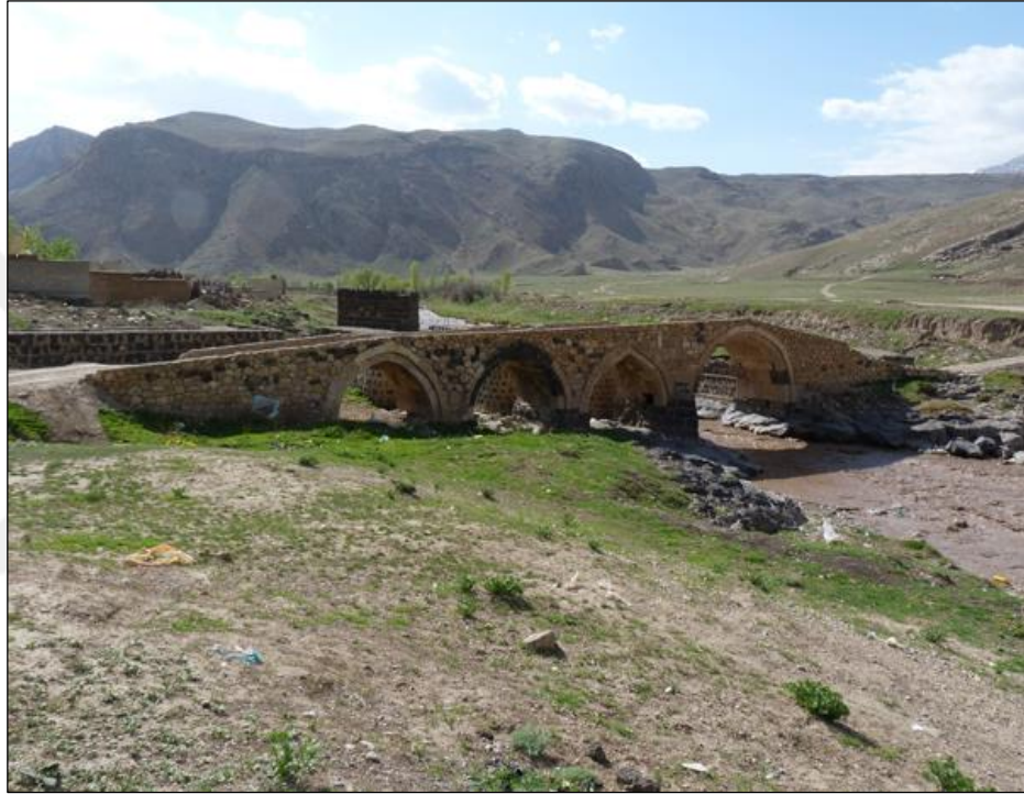
Fotoğraf 3.46. Köprüye Beş göz denilmesinin sebebi, Gacar döneminde sel tahribinden bozulan iki gözün bir büyük göze dönüştürülmesidir.
