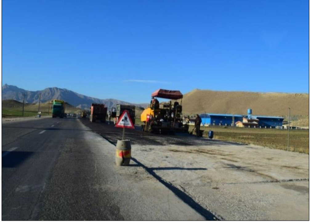
Fotoğraf 5.1. Maku –Bazergan güzergahında yol genişletme çalışması yapılmaktadır.
