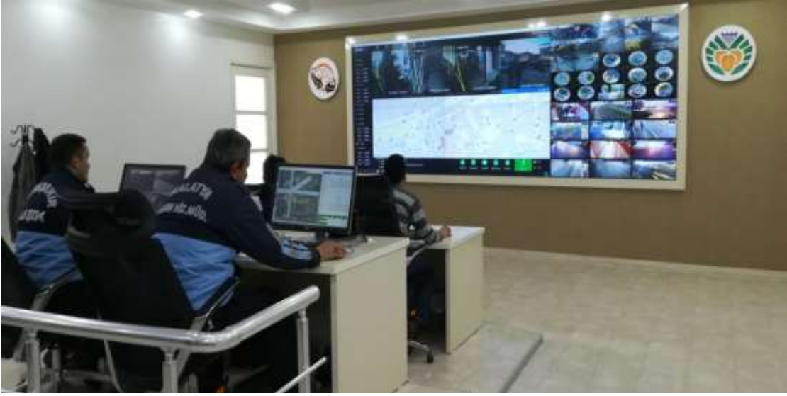
Şekil 3.3. AKS kontrol merkezi
