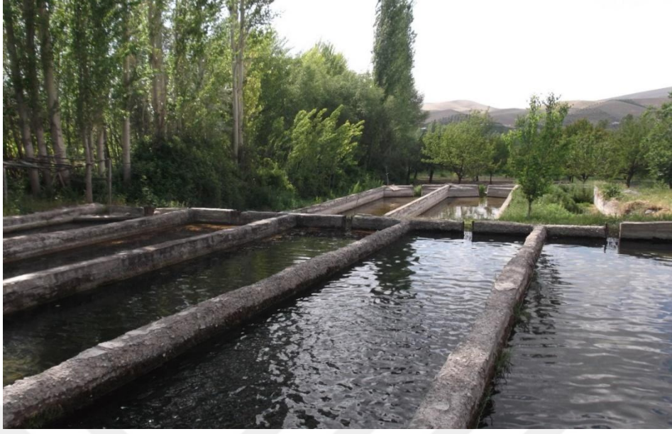
Şekil 3.1. Arıkan alabalık yetiştiricilik tesisi (Kuluncak/MALATYA) (Orjinal)
