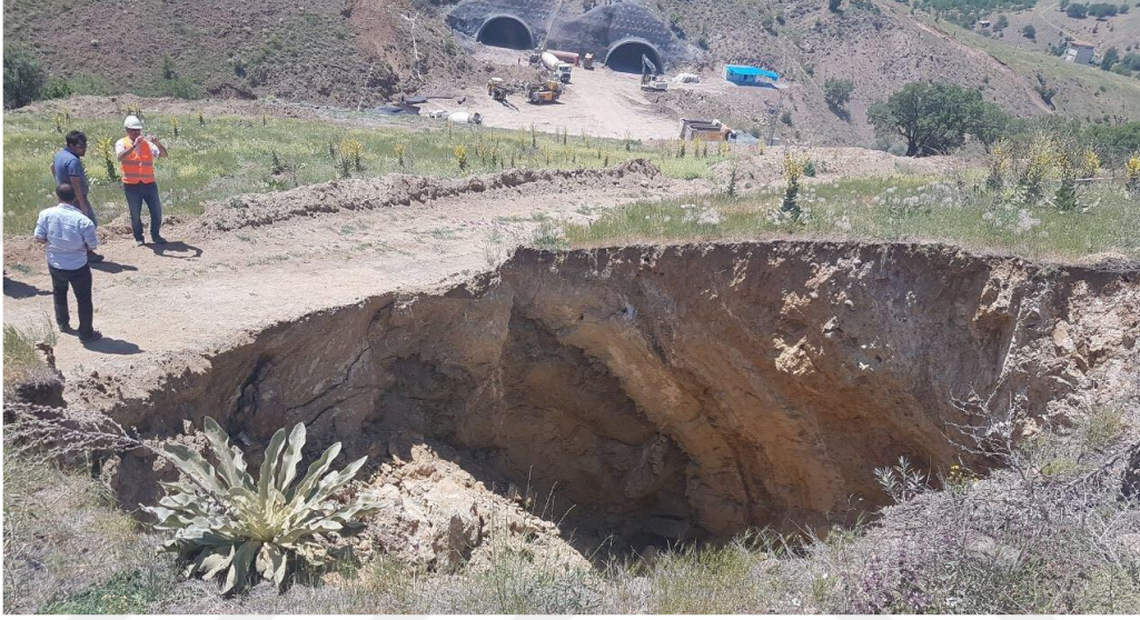
Resim 7.8. Sağ tüneli üstünde oluşan göçük krateri (Hasançelebi Malatya)
