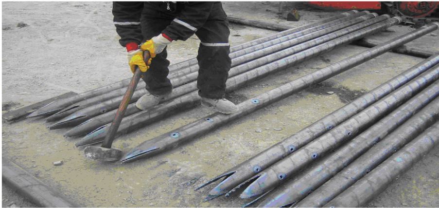
Resim 7.2. Umbrella Arch boruları
