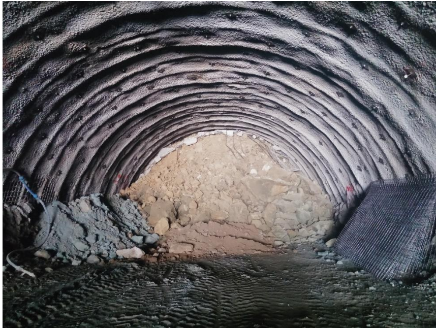
Resim 7.8. Sağ tüneli üstünde oluşan göçük krateri (Hasançelebi Malatya)
