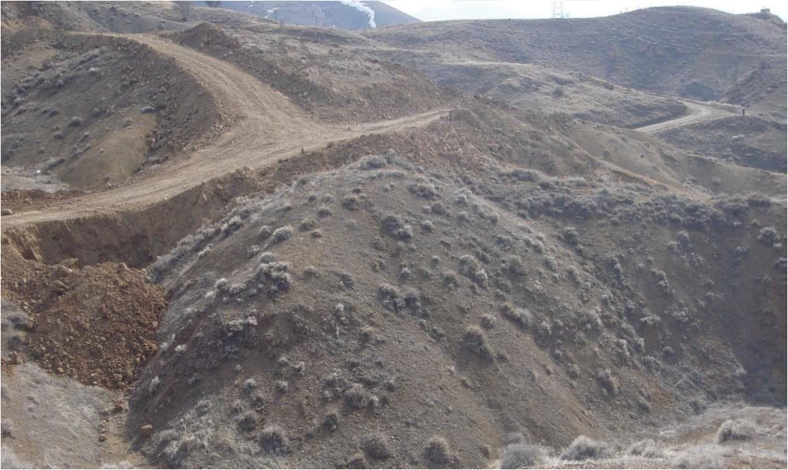
Resim 5.2. T2 Tüneli çıkış kesimine ait görünüm
