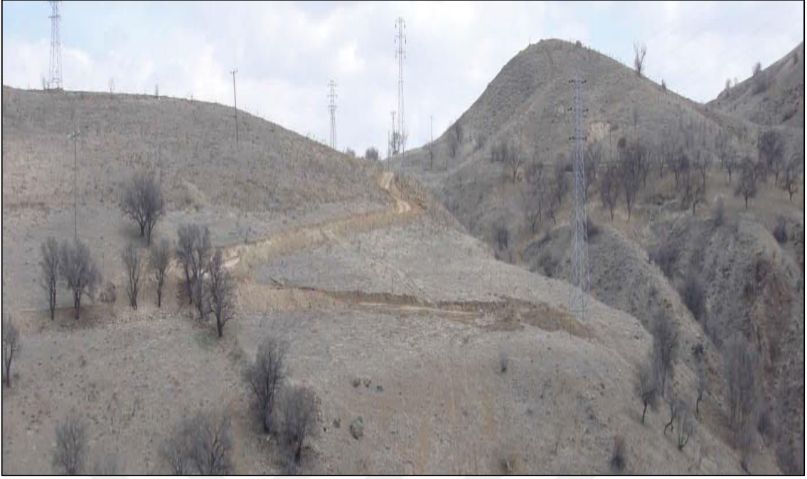
Resim 5.1. T2 Tüneli giriş kesimine ait görünüm (T1 Tüneli çıkışından bakış)
