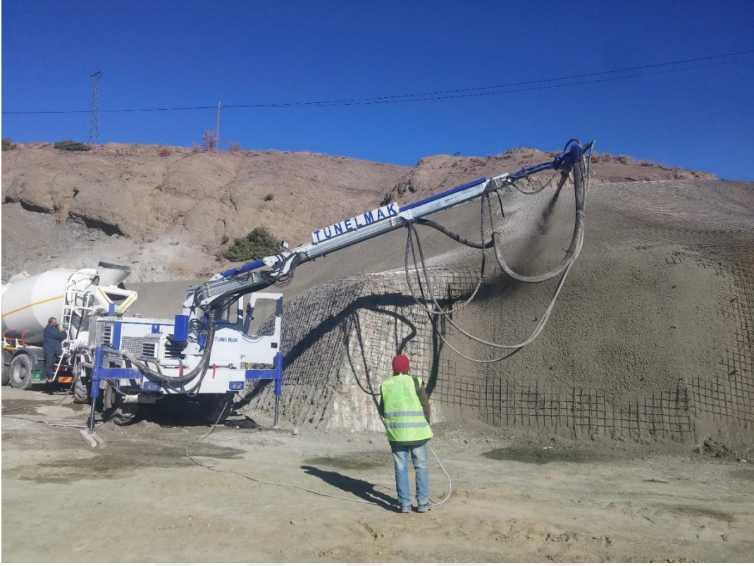
Resim 7.6. Robot kollu püskürtme beton makinası (Hasançelebi Malatya)
