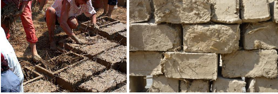
Resim 2.7. Saman ve çamurun birleştirilmesiyle meydana gelmiş kerpiç bloklar (URL-8),
