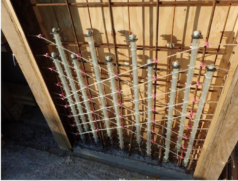
Resim 4.7. Beton dökümünden önce şekil hafıza polimer tendonları ve vasküler ağ kurulumu (Davies ve diğerleri, 2018).
