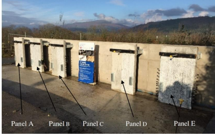
Resim 4.9. Saha deneme beton panelleri ( Davies ve diğ., 2016)
