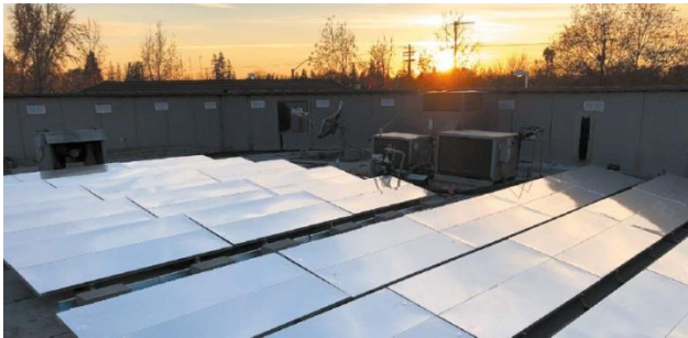
Resim 4.13. Kaliforniya' da bir binanın çatısına kurulan süper serin paneller (Lim, 2020)
