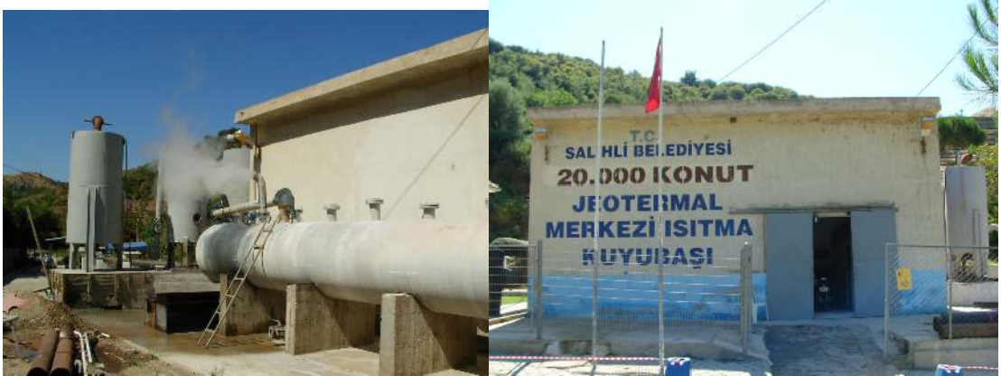
Şekil 3.4.1.3. K 3 kaynak ağızı ve kontrol altına alındığı tesis
