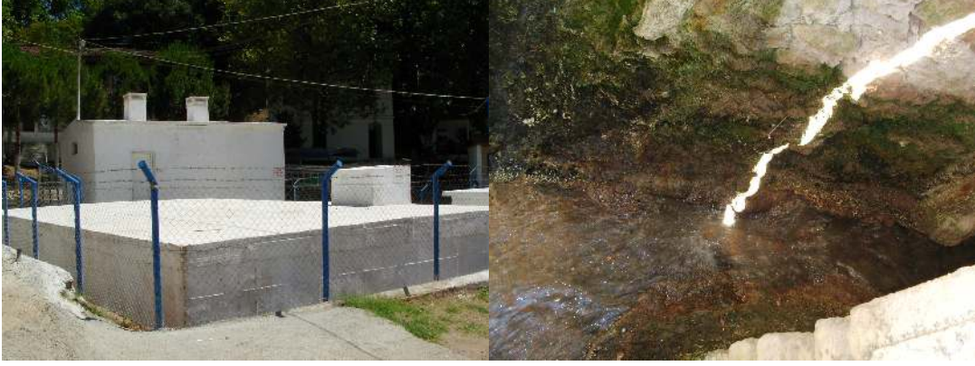
Şekil 3.4.2.1. Sart Kaplıcası suyun kaynaktan çıkışta toplandığı depo ve tek kaynak ağzı.
