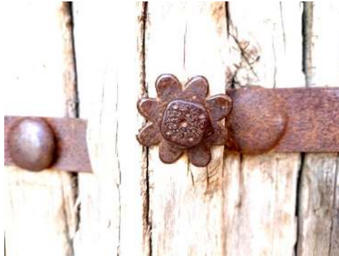
Görsel 386. Giriş açıklığını örten ahşap kapı kanadındaki sekiz yapraklı bitki formuna sahip bini aparatı
