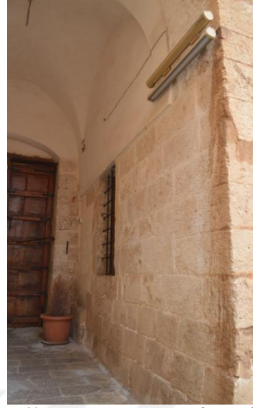
Görsel 43. Batı giriş eyvanının kuzey duvarı
