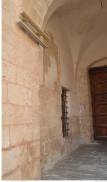
Görsel 42. Batı giriş eyvanının güney duvarı
