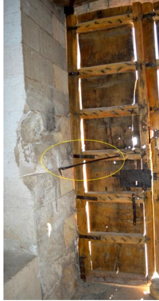
Görsel 380. Giriş açıklığındaki ahşap kapı kanatlarına montelenmiş uzun demir çubuk ve duvara çakılmış demir halka
