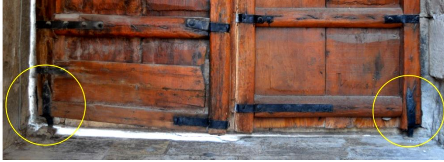
Görsel 18. Ahşap kapı kanatlarının zemine montelenmesini ve açılıp kapanmalarını sağlayan demir aparatlar
