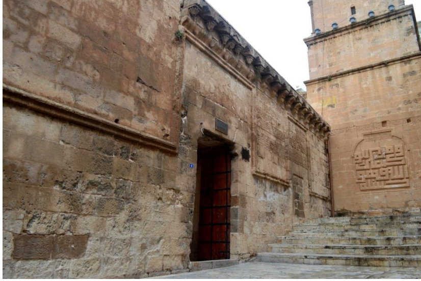
Görsel 6. Avlunun doğu duvarındaki taş kapı
