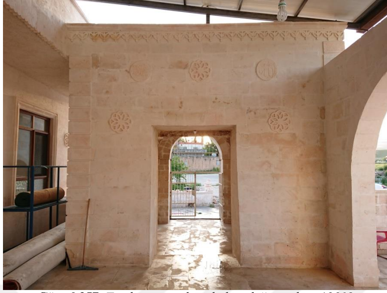
Görsel 257. Taç kapının avluya bakan doğu cephesi / 2019
