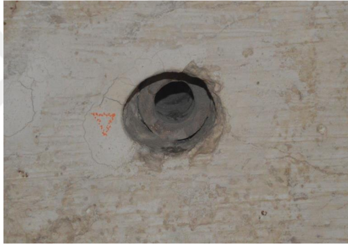
Görsel 242. Taç kapı giriş koridorunun kuzey duvarında bulunan dairesel formda delik içine yerleştirilmiş künk (büz)
