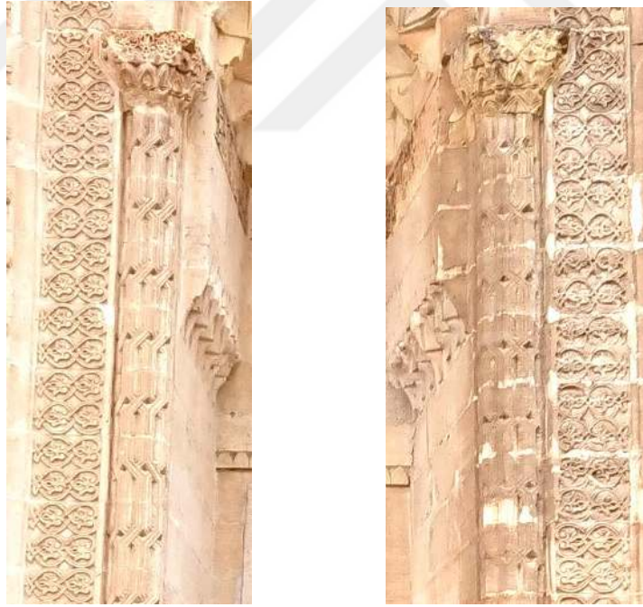
Görsel 110. Taş kapının kuzey ve güney yan kanatlarındaki köşe sütunceleri
