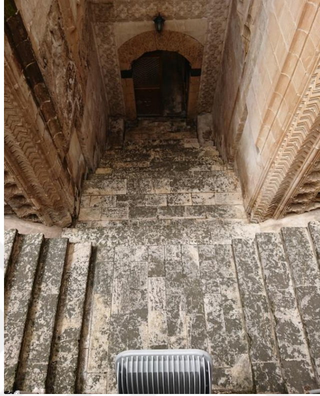
Görsel 291. Taç kapının merdiven kuruluşu ve sahanlığı
