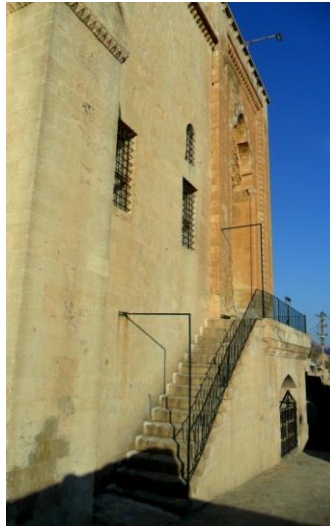
Görsel 354. Merdiven kuruluşu
