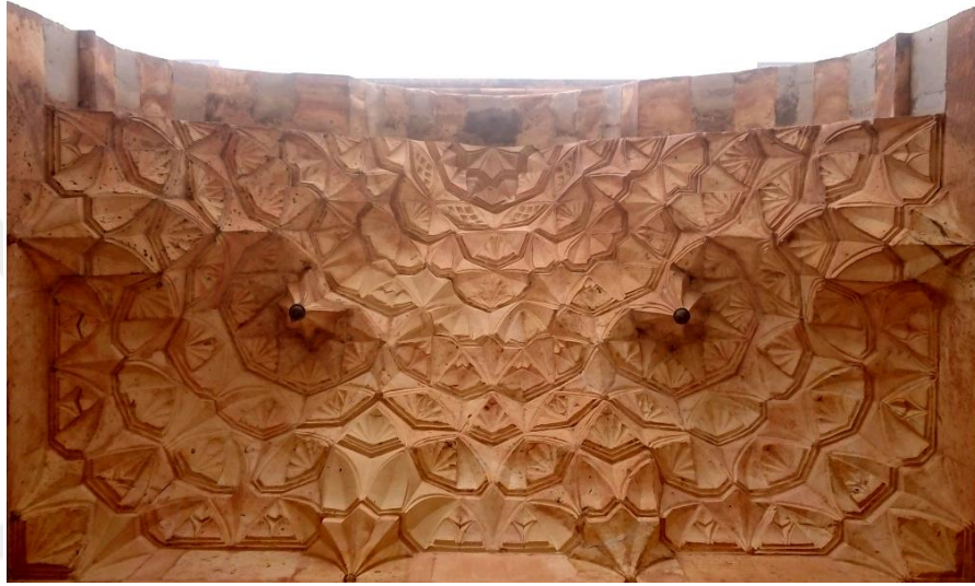
Görsel 166. Taç kapı nişinin üzerini örten mukarnaslı kavsaranın niş zeminin ortasından görünümü
