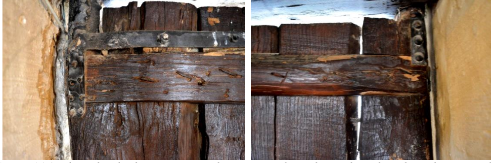
Görsel 116. Ahşap hatılın kuzey ve güney kenarına yerleştirilmiş, ahşap kapı kanatlarının açılıp kapanmasını sağlayan silindir formundaki demir elemanlar
