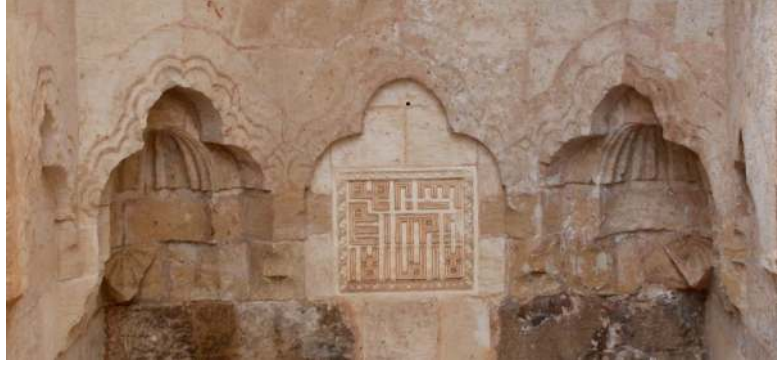
Görsel 300. Taç kapı nişindeki tromplar ve aralarına işlenmiş niş içindeki pano
