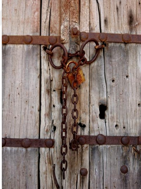
Görsel 378. Giriş açıklığını örten ahşap kapı kanatlarını zincirlemek için kullanılan küçük demir halkalar
