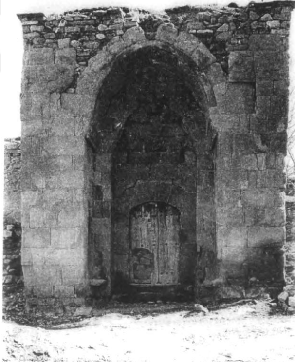
Görsel 403. Esadiye (Esediye/Arslanlı) Cami taç kapısı (VGM arşivi)
