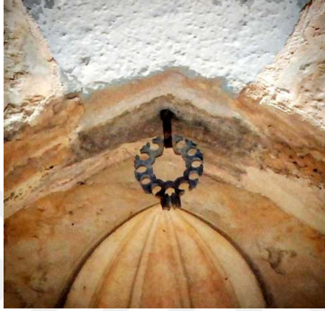
Görsel 165. Taç kapının kemer kilit taşının altına monte edilmiş, kandil asmak için kullanılan madeni aparat
