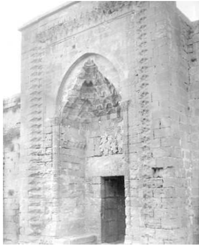
Görsel 98. Taç kapının kuzeydoğusu (Oppenheim, 1929) ( http://arachne.uni-koeln.de/item/marbilderoppenheim/6994 )
