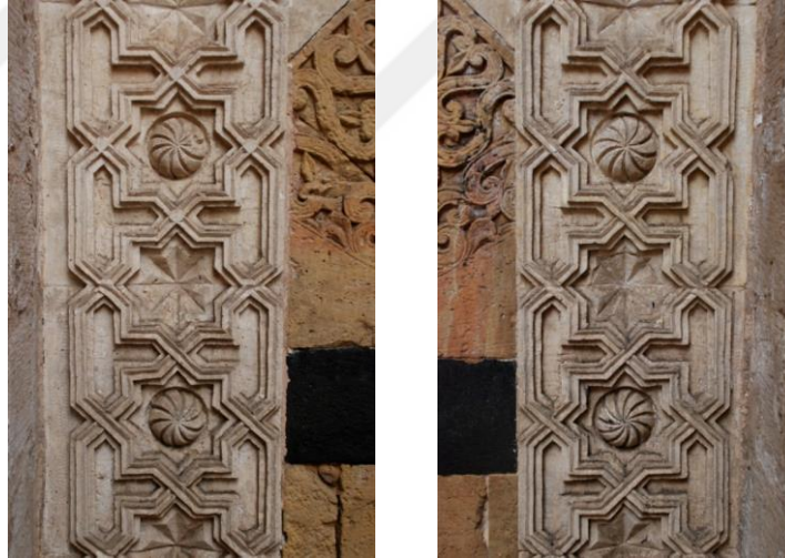
Görsel 316. Giriş açıklığını ters 'U' formunda dolanan, 2004 yılında, güney üst köşedeki orijinal parçaya göre tamamlanan süsleme şeridinin güney ve kuzey yan kollarından detay
