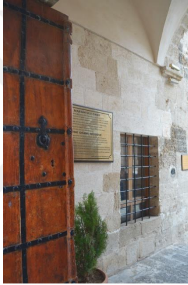
Görsel 25. Giriş eyvanının güney duvarı
