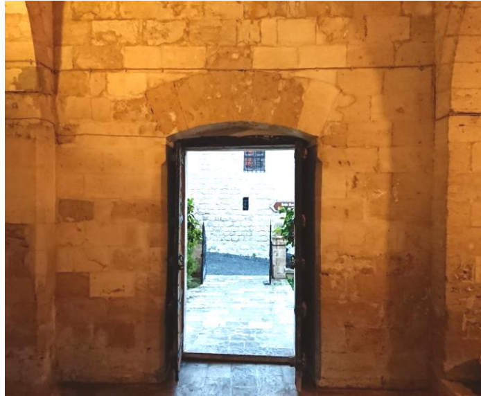
Görsel 125. Taç kapı iç mekânının doğu cephesi
