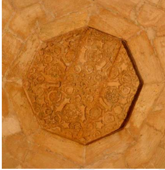
Görsel 130. Taç kapı iç mekânın yıldız tonozundaki çökertme kenarlı aynalık
