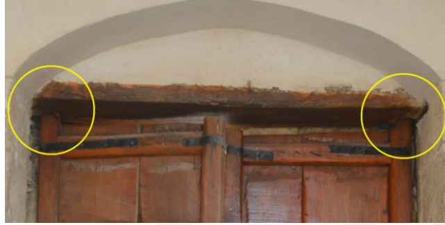
Görsel 36. Basık kemerin altındaki ahşap hatılın köşelerine oturan ahşap söveler
