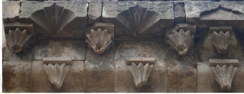
Görsel 22. Sarkıtların alttan görünümü ve uçlarındaki delikler
