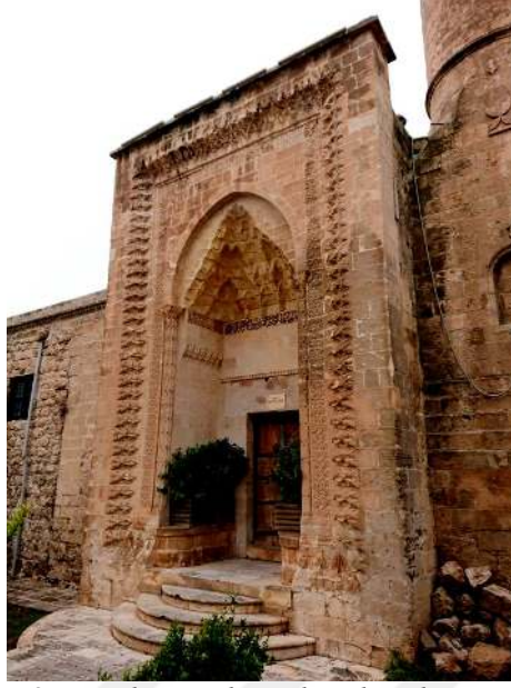
Görsel 97. Taç kapının kuzeydoğu köşeden görünümü
