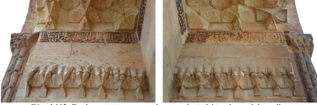
Görsel 112. Taç kapı nişinin güney ve kuzey cephesindeki mukarnaslı konsollar
