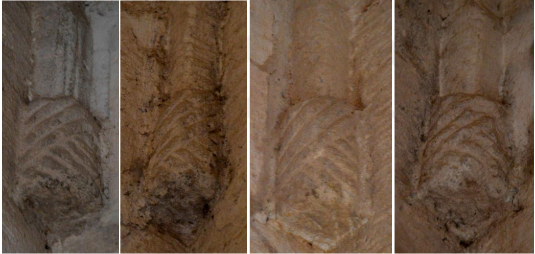
Görsel 129. Taç kapı iç mekânının yıldız tonozunu taşıyan duvarların dört köşesinde, yarısi duvara gömülü, kaval silme formundaki tonoz ayaklarının dışa taşkın olan kaideleri
