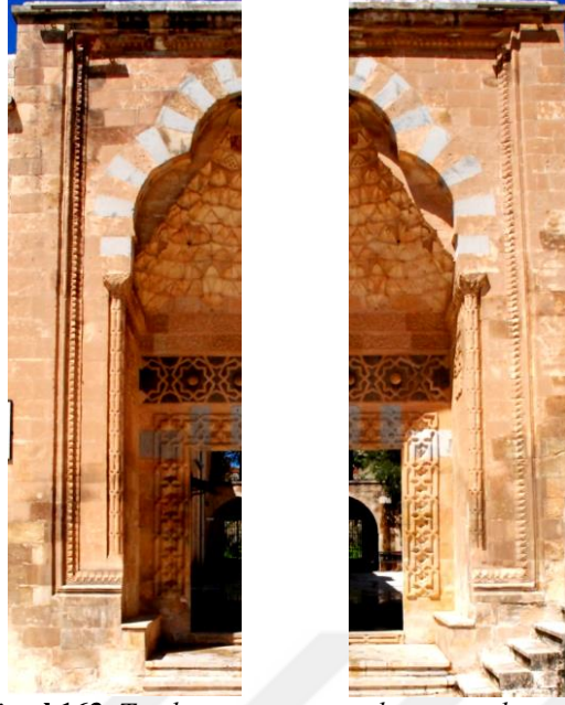
Görsel 163. Taş kapının güney ve kuzey yan kanatları
