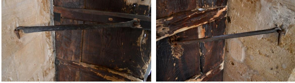
Görsel 120. Ahşap kapı kanatlarını destekleyen uzun demir çubuklar ve duvara monte edilmiş demir halkalar
