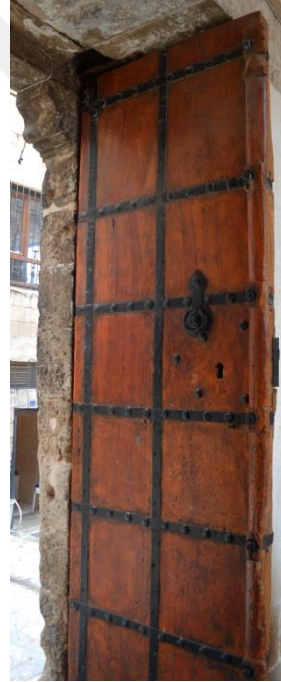
Görsel 16. Ahşap kapının güney kanadının ön yüzü
