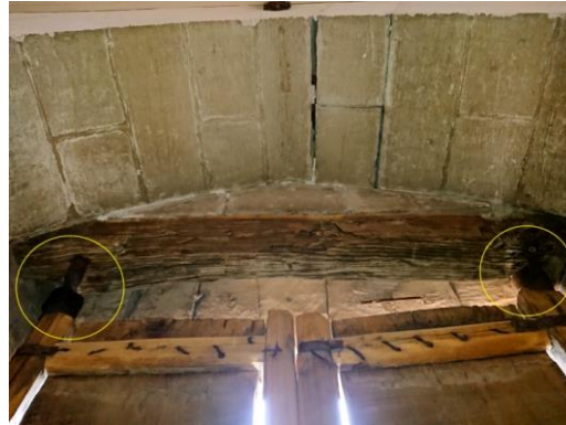
Görsel 376. Giriş açıklığındaki kalın ahşap hatılın doğu ve batı kenarlarına yerleştirilmiş, ahşap kapı kanatlarının açılıp kapanmasını sağlayan silindirik demir elemanlar
