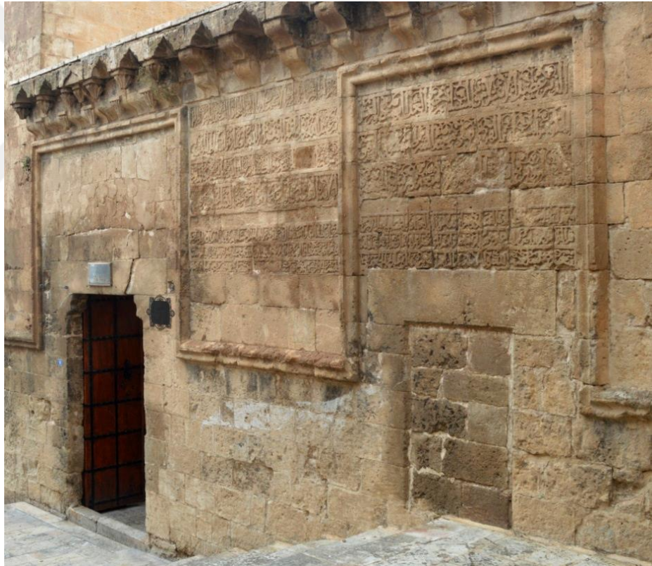
Görsel 8. Taş kapının günümüzde kuzeydoğudan görünümü ve kuzeyindeki vakıf kitabesi
