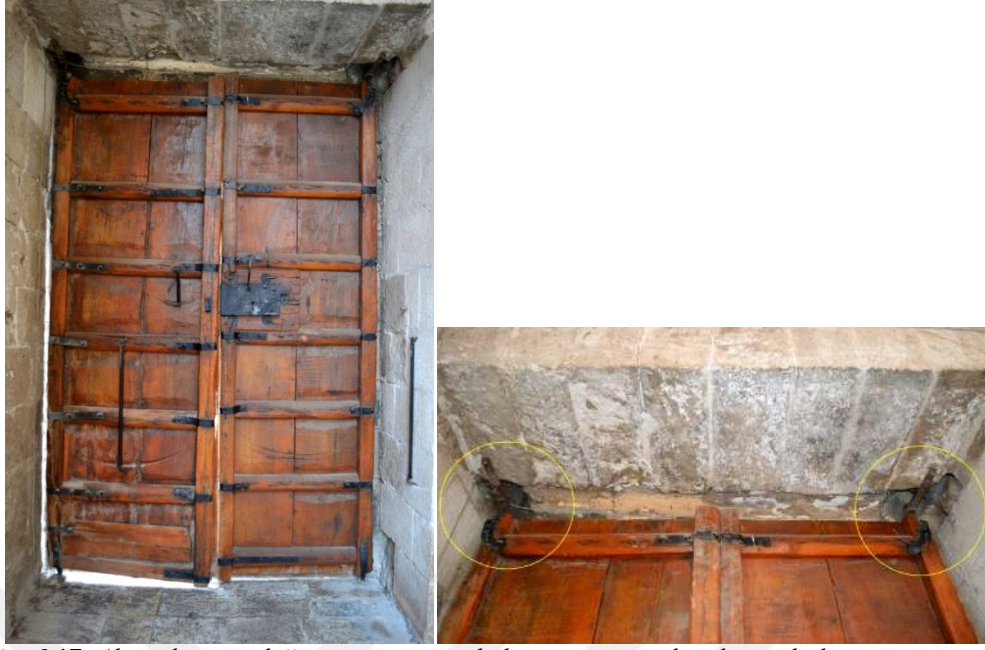
Görsel 17. Ahşap kapının doğu giriş eyvanına bakan yüzü ve üst köşelere sabitlenmesini ve açılıp kapanmasını sağlayan demir aparatlar
