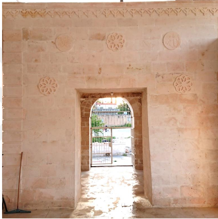
G rsel 269. Eyvan formundaki ta  kapının arka d zeni (doęu cephe)
