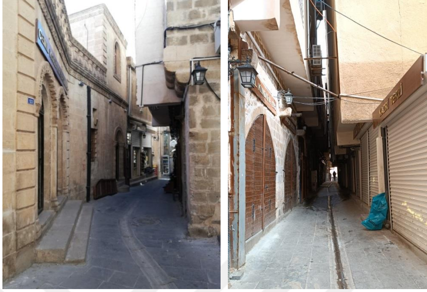
Şekil 4. 39. Demirciler Çarşısı Yüksek Katlı Yapılaşma (2022)
