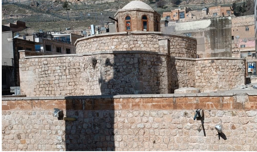
Şekil 4. 17. Emir Hamamı Sıcaklık Bölümü Görünümü (2022)
