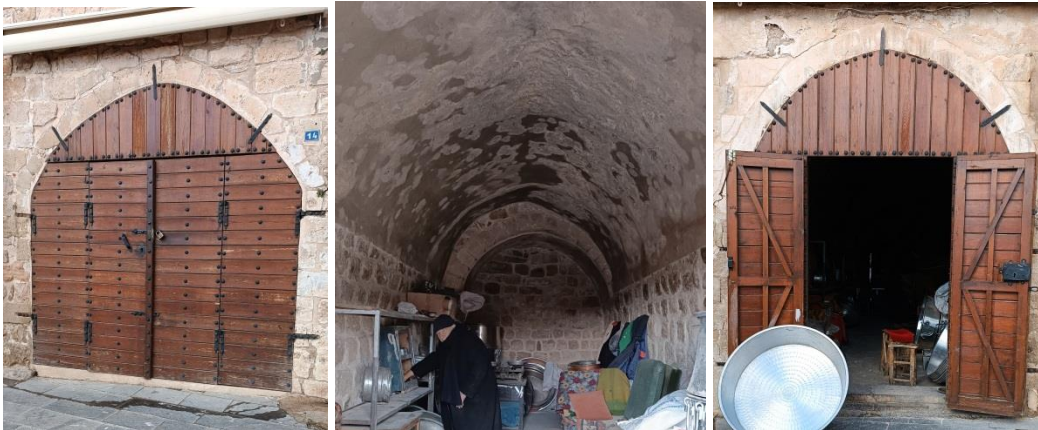
Şekil 4. 74. (Soldaki)Yarım Daire Kemerli, (Sağdaki) Sivri Basık Kemerli Dükkan Girişi, (Ortadaki) Beşik Tonoz (2022)
