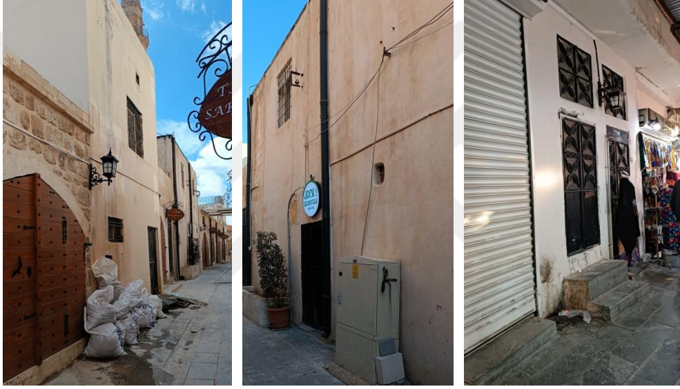
Şekil 4. 170. Rekonstrüksiyonlu Bina (soldaki, ortadaki) (2022), Betonarme dokuyla uyumsuz yapı (sağdaki) (2022)
