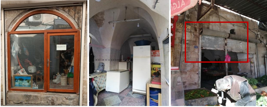
Şekil 4. 102. Yarım Daire Kemerli Giriş (Soldaki), Çapraz Tonoz (Ortadaki), Betonarme Lento Giriş (Sağdaki) (2022)
