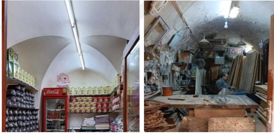
Şekil 4. 28. Marangozlar Çarşısı çapraz tonoz ve beşik tonoz örnekleri (2022)
