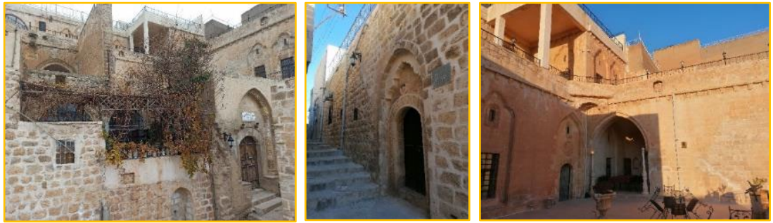
Şekil 3.16 Kasrı Abbas Pansiyon (KA, 2023)
