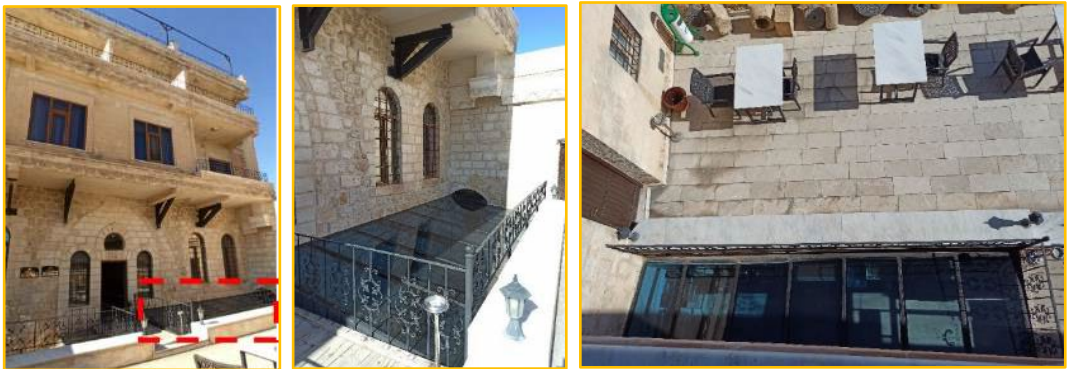
Şekil 4.29 Gazi Konağı Otel açık büfe alanı üstünde cam tavan uygulaması
