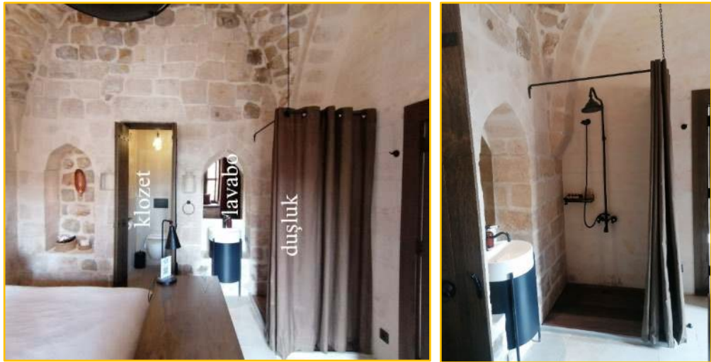
Şekil 4.48 Islak hacmin odada 3 ayrı bölümde çözülmesi Mirsoum Otel örneği
