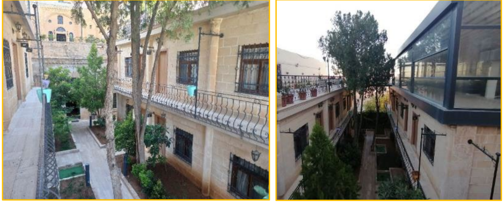
Şekil 4.28 Mardin Osmanlı Konağı avlusunda yer alan ek oda mekânları
