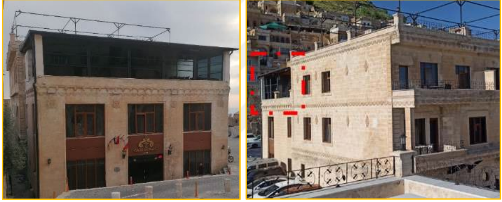
Şekil 4.23 Gazi Konağı Otel damının sonradan camekân alana dönüştürülmesi
