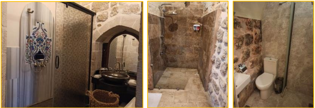
Şekil 4.50 Islak hacim taş yüzeylerinde kısmi kaplamanın uygulanması soldan sağa; Mardius Tarihi Konak, Darius Konağı, Merdin Butik Otel
