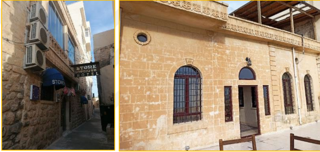
Şekil 3.8 Stone Otel; solda güney cephesi, sağda 2. Kat terası güney cephesi (KA, 2023)
