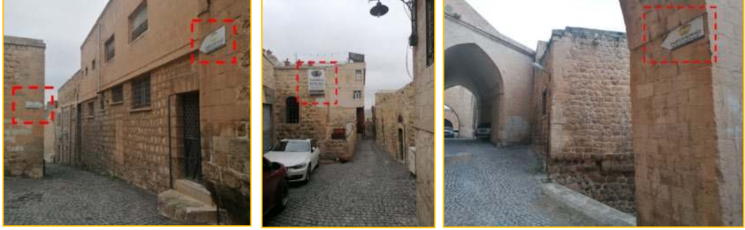
Şekil 4.9 Otele yakın yapı/yüzeylerde tabela kullanımı Darius Konağı örneği
