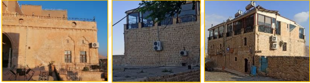
Şekil 5.6 Klima dış ünitesinin görünür cephelerde olduğu örnekler; soldan sağa Kasrı Abbas Pansiyon, Darius batı ve doğu cephesi
