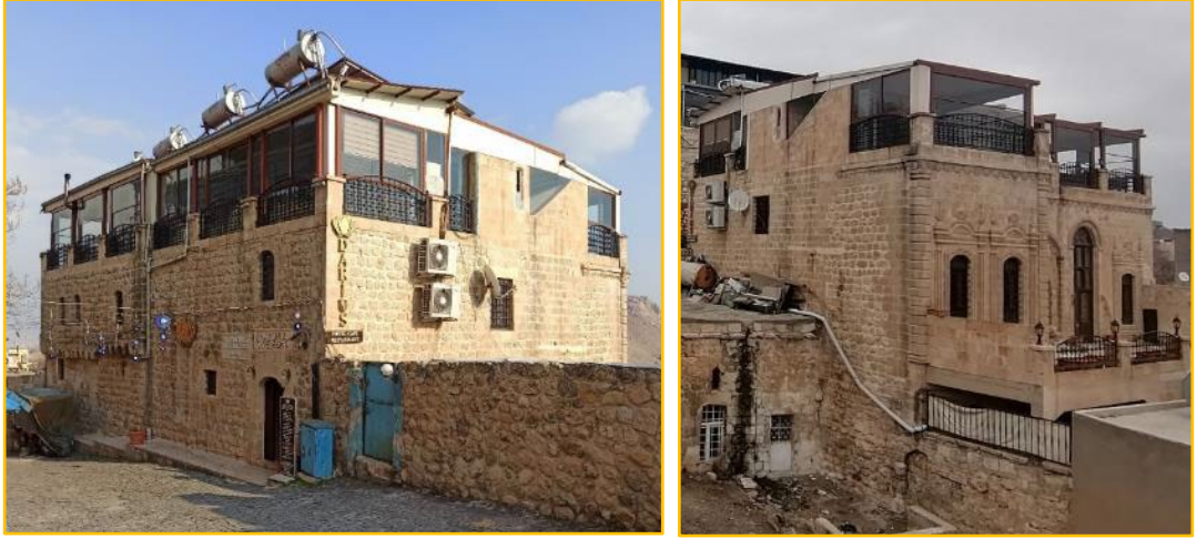
Şekil 3.21 Darius Konağı (KA, 2023)
