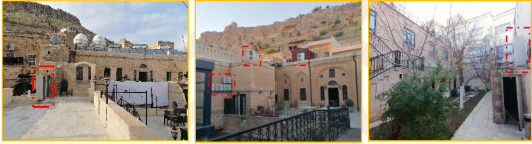
Şekil 4.15 Klima dış üniteleri konumu soldan sağa; Fairouz Konağı, Mardin Osmanlı Konağı Otel, Maridin Otel
