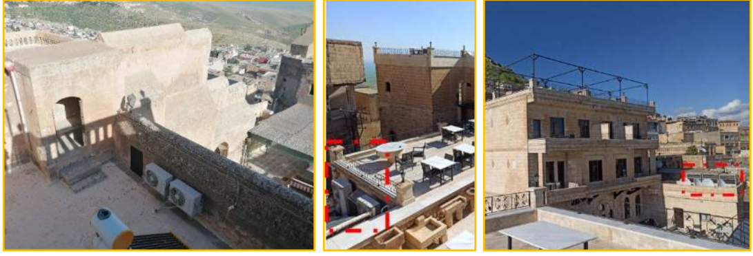
Şekil 5.5 Klima dış ünitesinin teras veya damda konumlandırıldığı yapı örnekleri; soldan sağa Maristan Tarihi Konak, Gazi Konağı Otel cephesi, Gazi Konağı Otel damı
