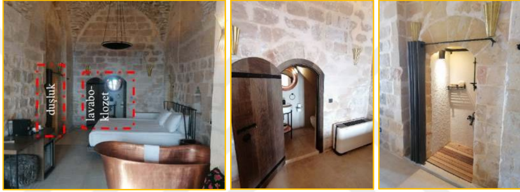
Şekil 4.47 Islak hacmin odada 2 ayrı bölümde çözülmesi Mirsoum Otel örneği
